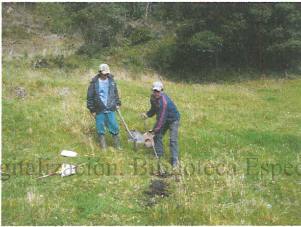
Fotografía 9. Realización de apiques o pozos de sondeo
