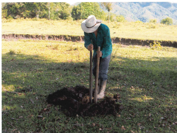
Foto 4.1.2. Realización de pozos de sondeo. Atrás se observa la vía de acceso.
