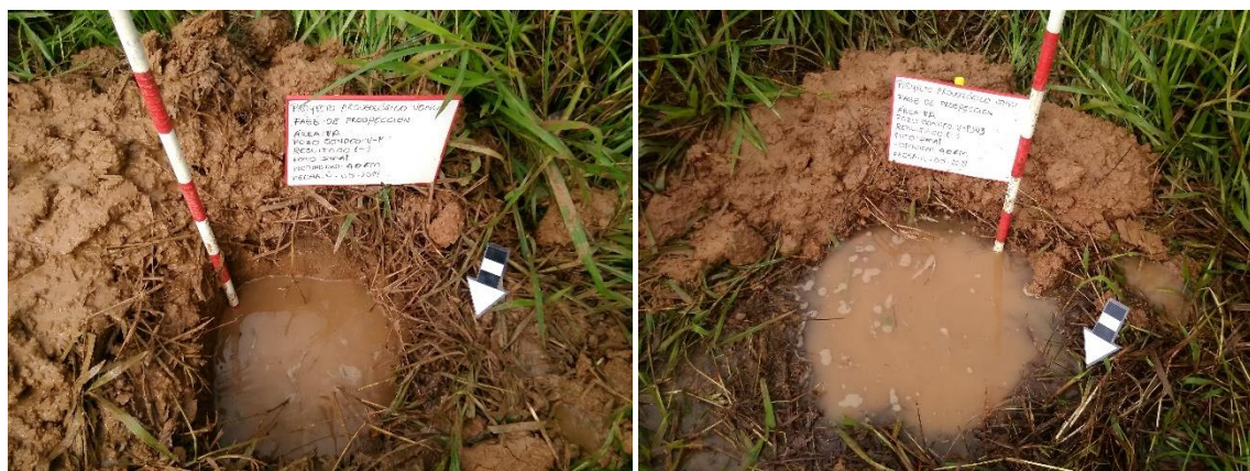
Fotografía 27 Detalle de pozos de sondeo en el corredor lineal para la vía de acceso y facilidades, en los que se registró un nivel freático alto.
