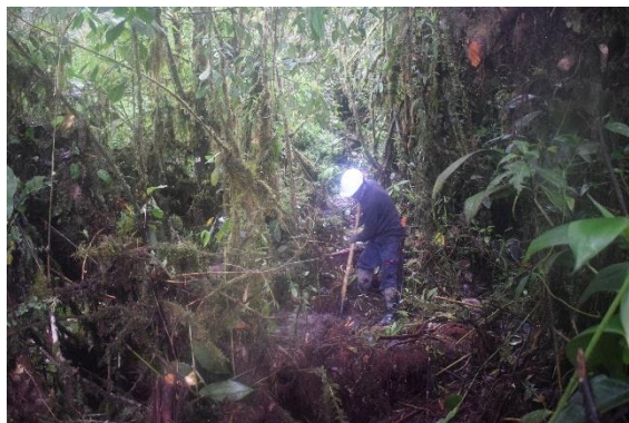
Fotografía 8 Apertura de pozo de sondeo
