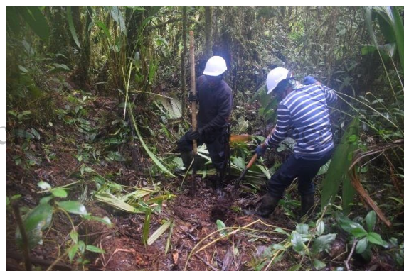
Fotografía 9 Apertura de pozo de sondeo
