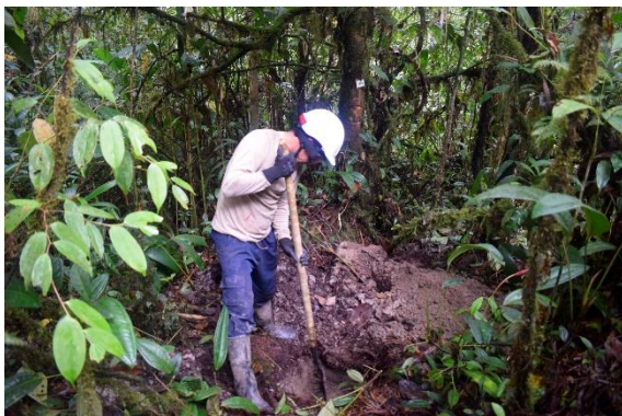
Fotografía 7 Apertura de pozo de sondeo
