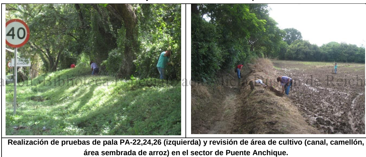
Fotos 22 y 23. Sector de Puente Anchique
