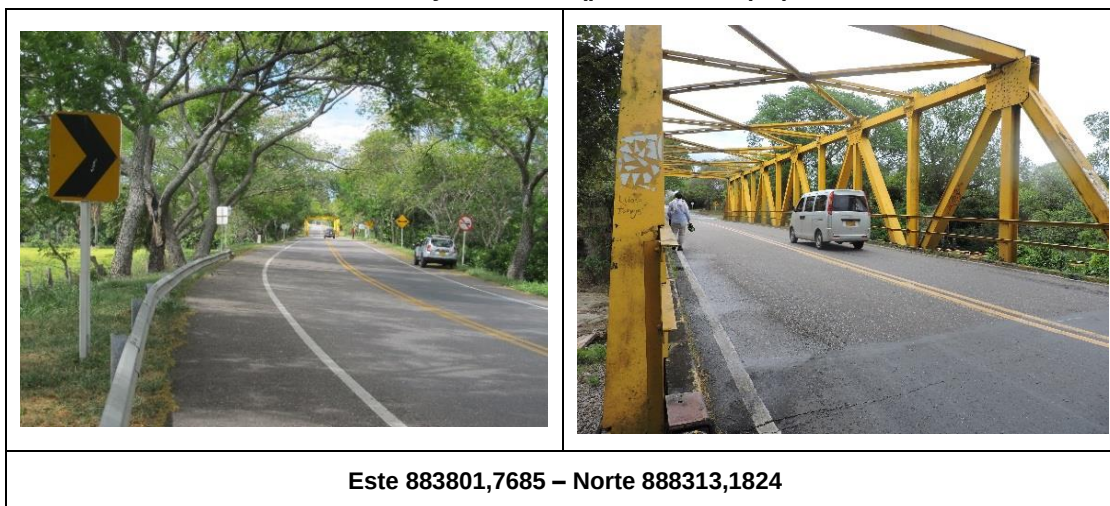
Fotos 2 y 3. Red Vial (puente Anchique)
