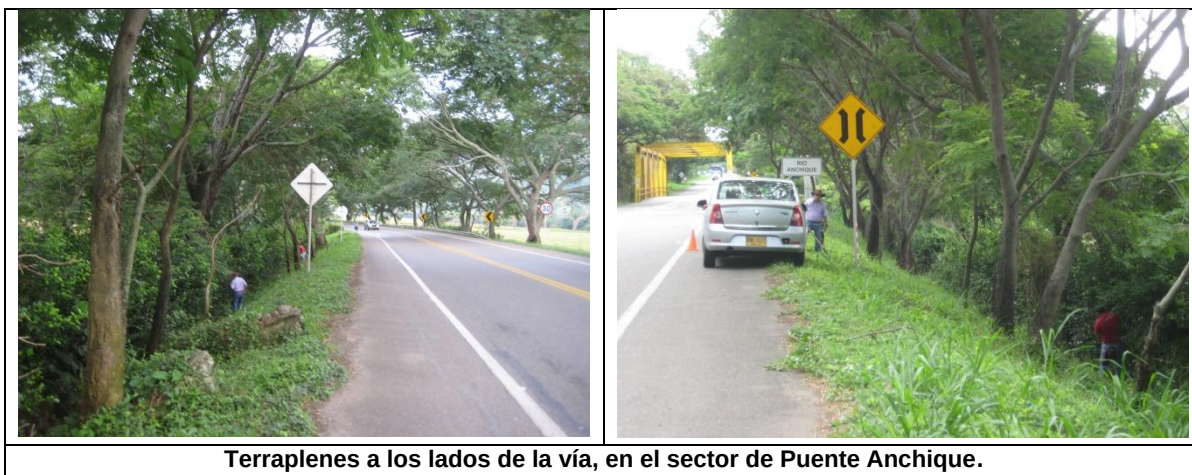
Fotos 12 y 13. Terraplenes Puente Anchique
