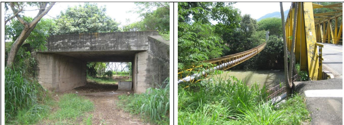
Box coulvert vía, puente existente, tubería de acueducto y río Anchique en el sector de Puente Anchique.
