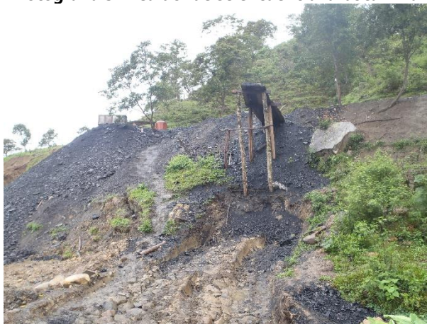
Fotografía 5 Área donde se encuentra la bocamina
