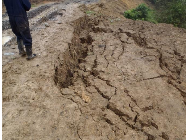
Fotografía 6 área con desprendimiento de tierra en la mina Reina III
