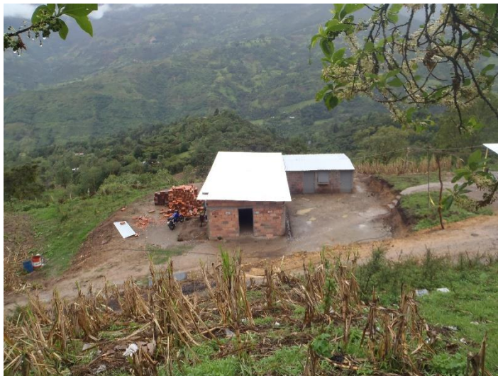
Fotografía 4 Campamento de la mina Reina III
