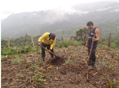
Fotografía 7 Apertura de pozos de sondeo cerca al campamento
