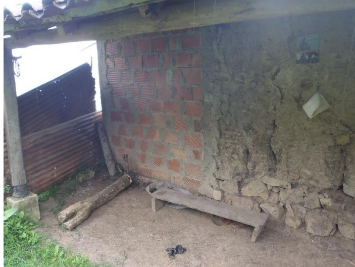
Fotografía 15 Muro reconstruido con ladrillo dentro de la casa de tapia
