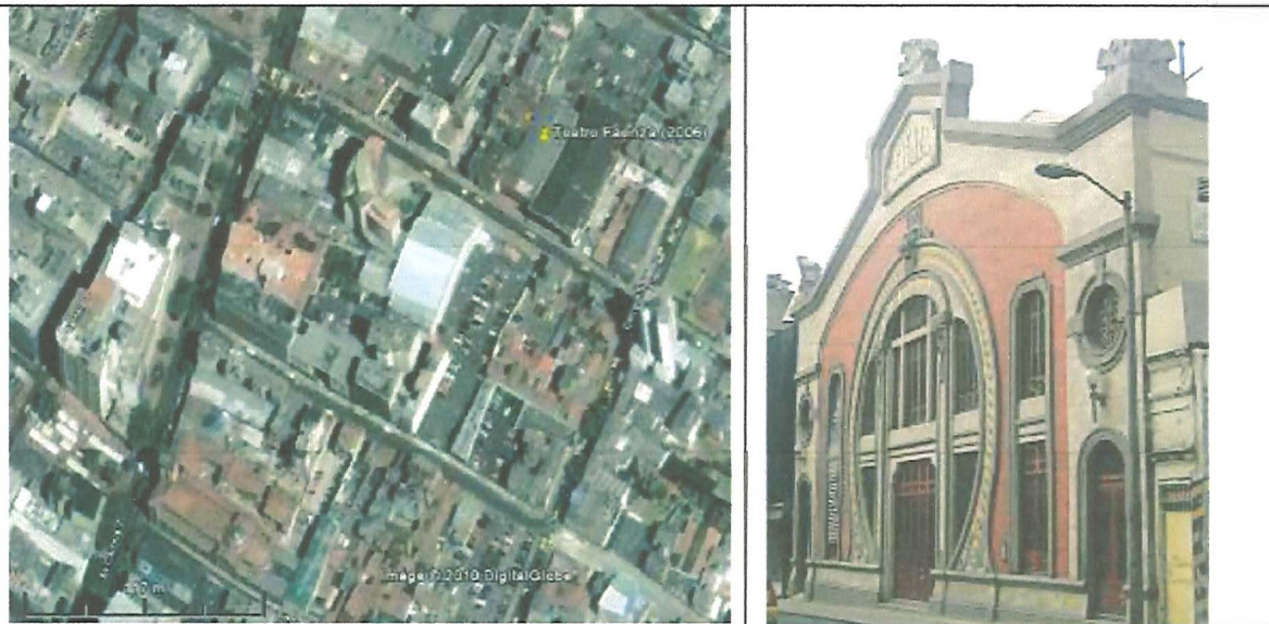
Figura. 18 Ubicación general y vista de la fachada del Teatro Faenza (Fuente Imagen: Google Earth, 2010)
