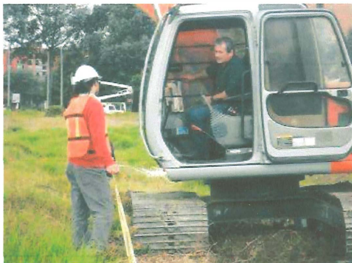
Figura 35 Coordinación de labores con el operario de maquinaria pesada
