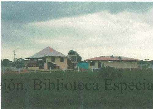
Fotografía 8 Vista de la construcción del balneario Paqari
