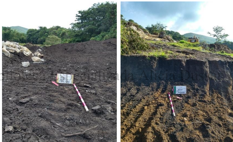
Fotografía 21 Monitoreo de descapote y excavación Plataforma
