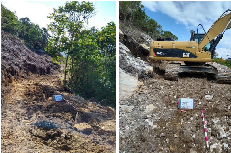
Fotografía 24 Descapote y excavación K1+001 a K2+000
