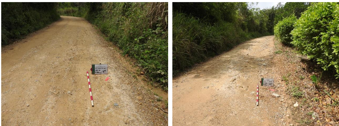
Fotografía 28 Registro fotográfico vía antigua K5+400 y k5+600
