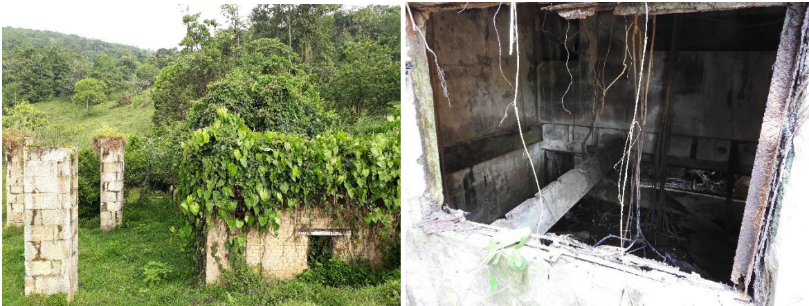
Fotografía 1 Ruinas del beneficiadero. Hacienda La Aguada
