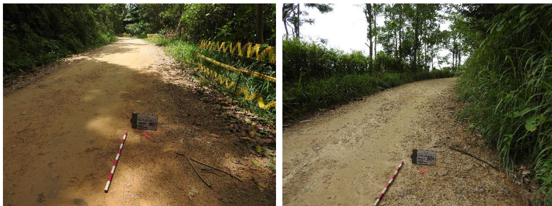
Fotografía 27 Registro fotográfico vía antigua K4+200 y K4+800
