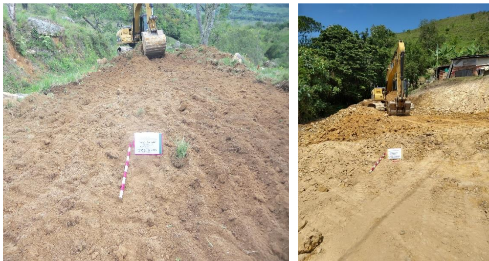
Fotografía 26 Descapote y excavación K3+001 a K3+500
