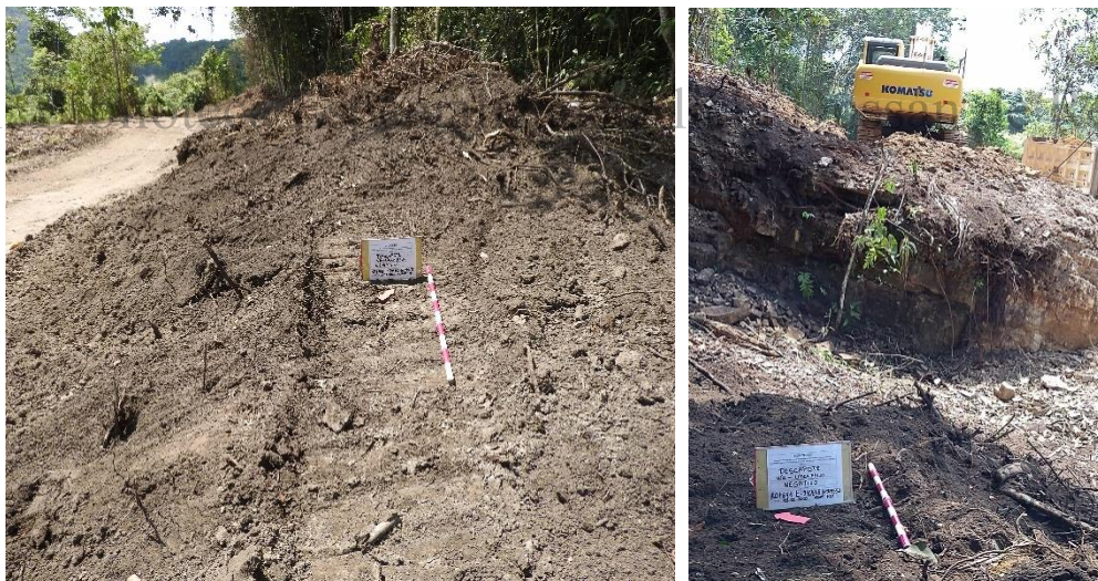
Fotografía 23 Descapote y excavación K0+000 a K1+000
