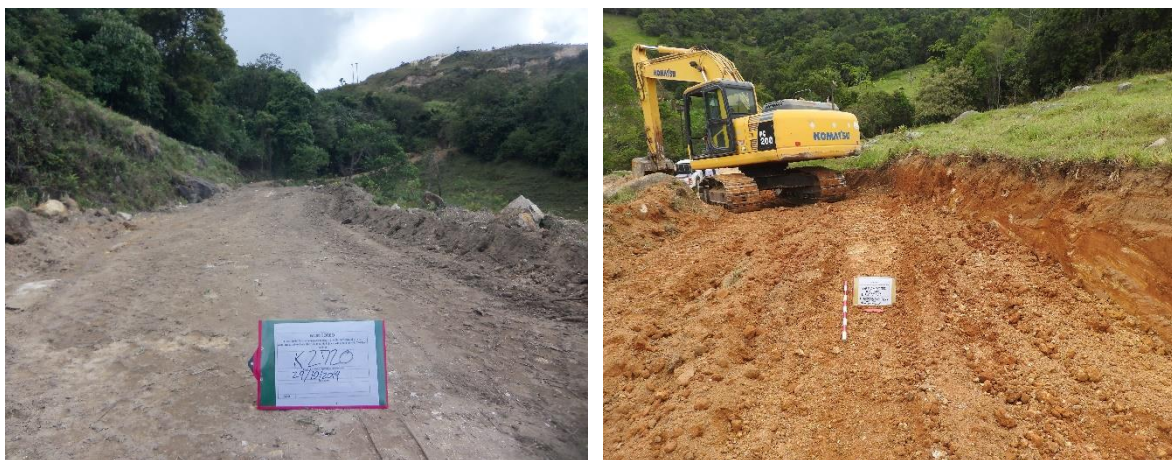
Fotografía 25 Descapote y excavación K2+001 a K3+000
