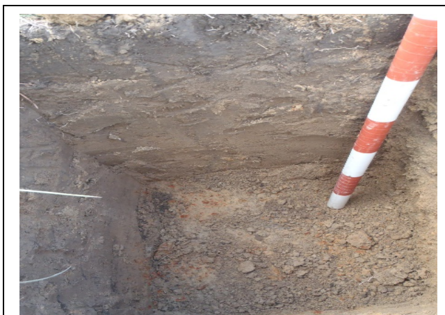
Fotografía 3. Pozo de sondeo PN3HP103 con suelos arenosos en su perfil
