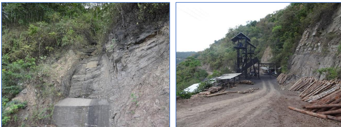
Fotos N°34 y 35. Escarpe con cañada seca. Tolva del Inclinado 7.
