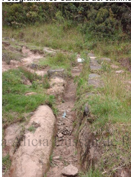
Fotografía 4-39 Canales del camino
