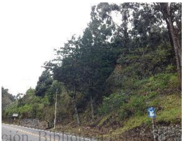
Fotografía 4-3 Muros de contención en el punto de observación -P1DC1- del Polígono 1
