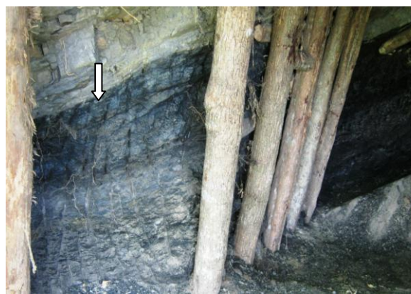
Foto 14: Detalle manto de carbón en el perfil de la entrada Bocamina 2.
