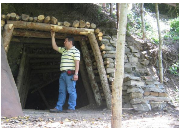
Foto 13: Entrada Bocamina 2. Coordenada: 1155731 E – 1365757 N
