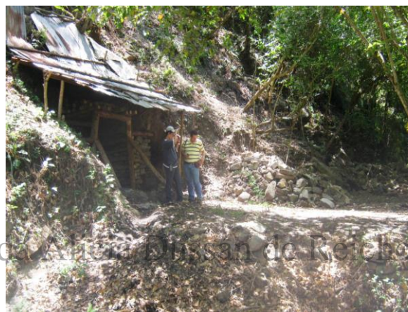
Foto 12: Ubicación Bocamina 1 en la base de eskarpe.
