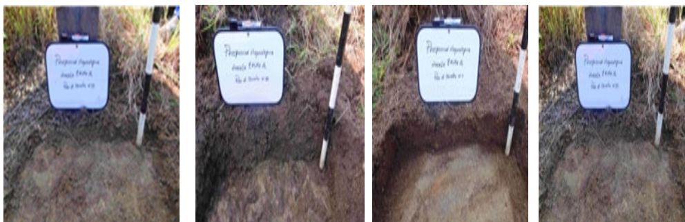
ILUSTRACIÓN 6. POZOS DE SONDEO 5-8-11-16-16-19-7-21 DE LA UMA 4. MODULO 2
