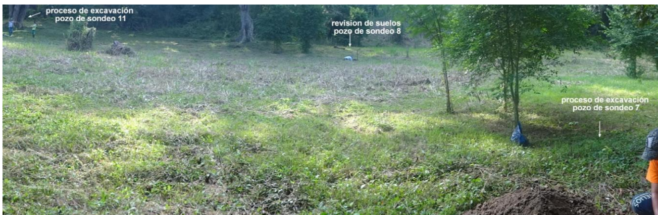
Panorámica zona de infraestructura minera y proceso de excavación de los pozos 7 y 11, e inspección de suelos del pozo de sondeo 8, imagen tomada desde el pozo de sondeo 7.
