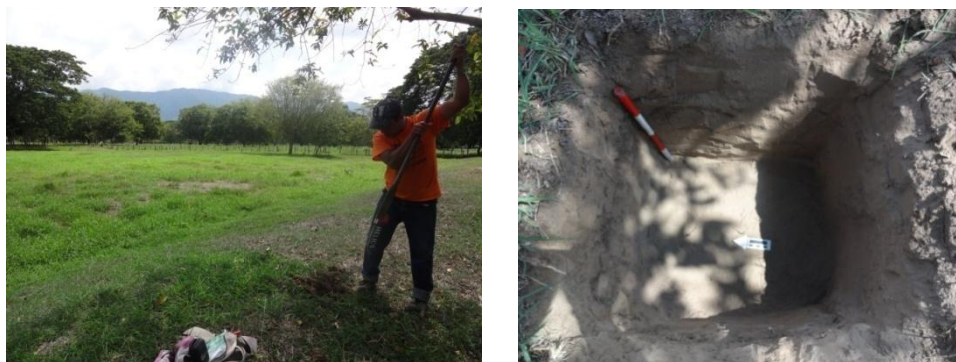
Izquierda: Proceso de excavación pozo de sondeo 15. Derecha: final de excavación pozo de sondeo 15.
