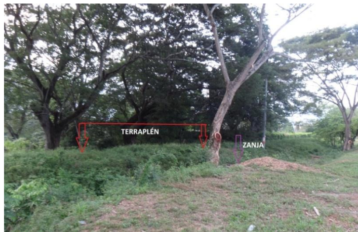
Terraplén y zanja que hicieron parte del trazado del ferrocarril de La Dorada.
