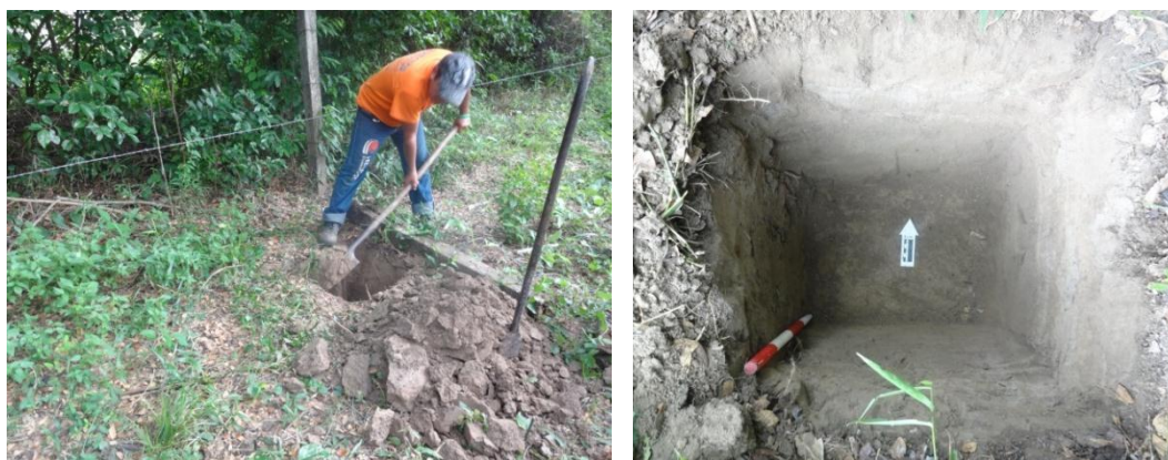
Izquierda: proceso de excavación pozo de sondeo 6. Derecha: final de excavación pozo de sondeo 6.
