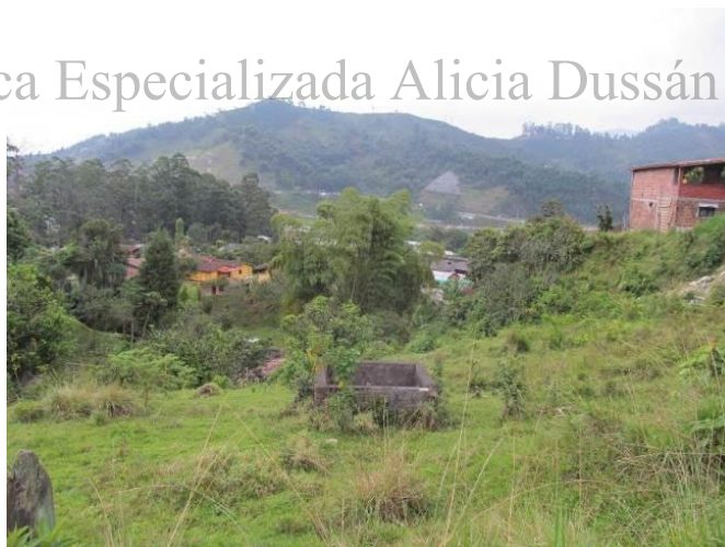
Foto 26. Pequeño tanque de agua de 2 x 2 m ubicado sobre la terraza 5.
