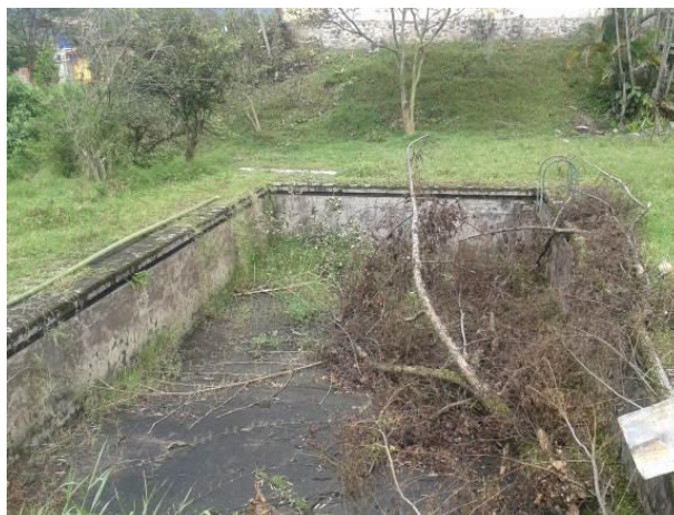
Foto 28. Piscina de mayor tamaño, cuya excavación seguramente altero los suelos hasta una profundidad de 2 m.
