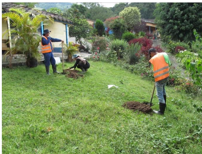
Foto 17. Casa mayordomo con antejardín y vía de acceso a la casa principal.
