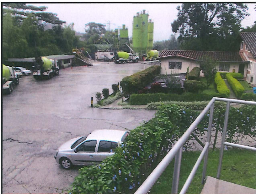
Foto No. 5. Vista hacia el norte de la Planta, se aprecia que el sitio está completamente construido.
