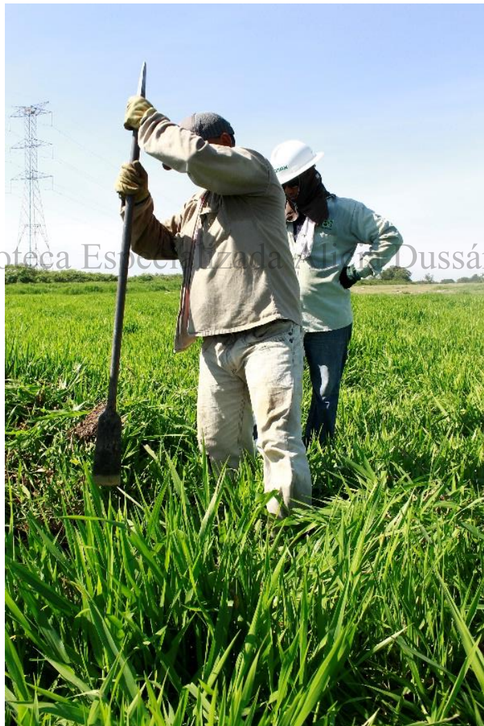
Fotografía 1 Realización pozo de sondeo
