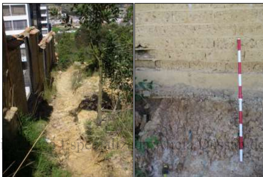
Figura 27. Intervenciones a lo largo del muro perimetral.
