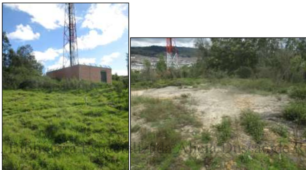
Figura 24. Parte anterior (izq.) y posterior (der.) de la torre de telefonía, en que se ve un aterrazamiento artificial.
