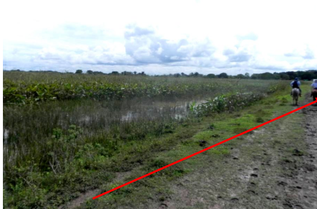
Foto N° 16. Vista del trazado de la línea de flujo, aproximadamente a 800m de distancia de la plataforma Yopo 1. Se aprecia que toda el área es inundable, por ese motivo se construye el terraplén y sobre este la vía. La vegetación predominante es típica de áreas fangosas. La flecha señala el sitio donde se instalaría la línea de flujo.
