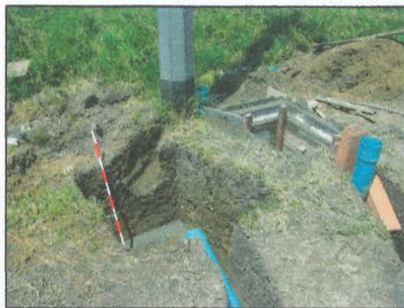
Foto 49. Perfil en obras. Área UIA2.
