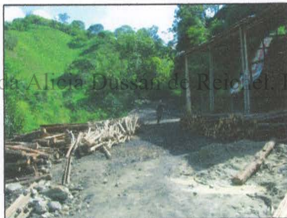
Foto 15. Sector Patio de Acopio
