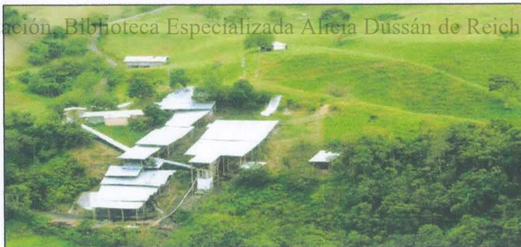
Foto 3. Obras de Infraestructura Sector 1 (imagen este-oeste).
