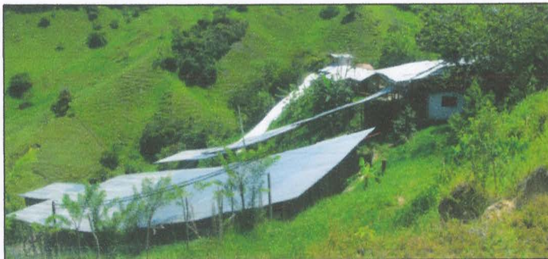
Foto 2. Obras de Infraestructura Sector 1 (imagen sur-norte).
