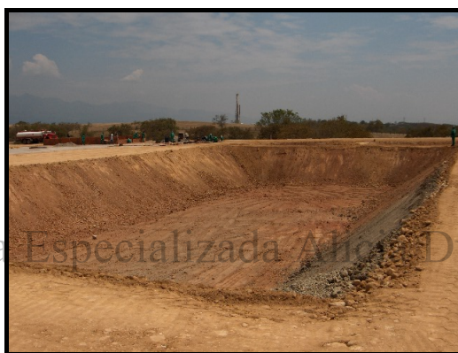
Foto 4.2.1.7 Seguimiento a las obras civiles en la locación
