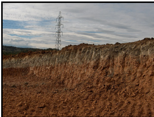
Foto 4.2.1.5 Seguimiento a las obras civiles en la locación
