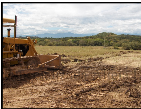
Foto 4.2.1.4 Seguimiento a las obras civiles en la locación
