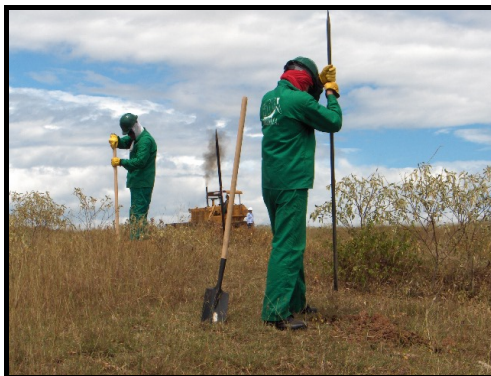
Foto 4.2.1.3 Realización de pozos de sondeo en el área de la locación.
