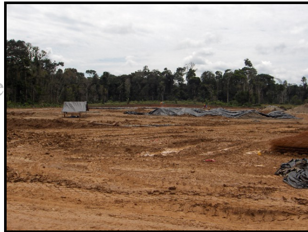
Foto 4.1.1.3 Seguimiento a las obras civiles en la locación.
