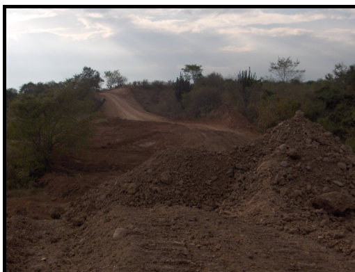
Foto 4.3.1.6 Seguimiento a las obras civiles en la vía de acceso
