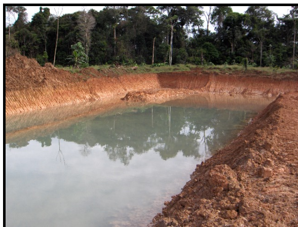
Foto 4.1.1.4 Seguimiento a las obras civiles en la locación
