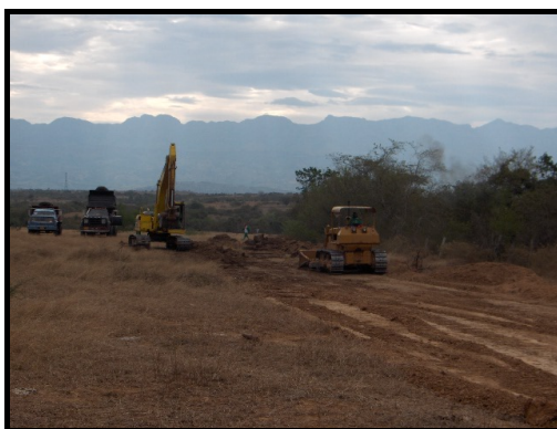
Foto 4.3.1.5 Seguimiento a las obras civiles en la locación
