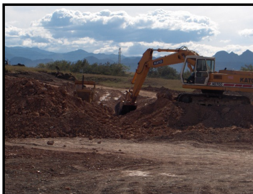
Foto 4.2.1.6 Seguimiento a las obras civiles en la locación
