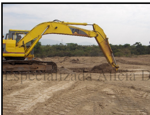
Foto 4.3.1.7 Seguimiento a las obras civiles en la locación
