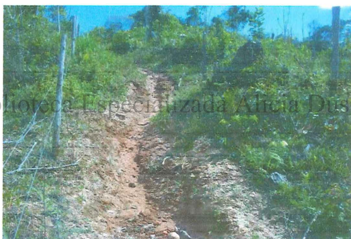
Fotografía 25. Tipo de suelos que afloran en el área de la vía de acceso.
