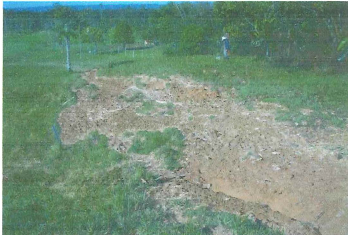
Fotografía 12. Áreas erosionadas propicias para la realización de inspecciones superficiales.
