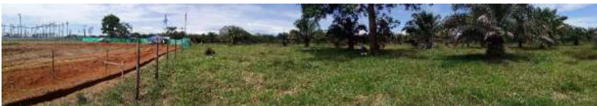
Fotografía 26 Punto de Observación. Paisaje asociado a la Torre 23 nótese la construcción del Centro de distribución eléctrica Acacias CDK (izq).
