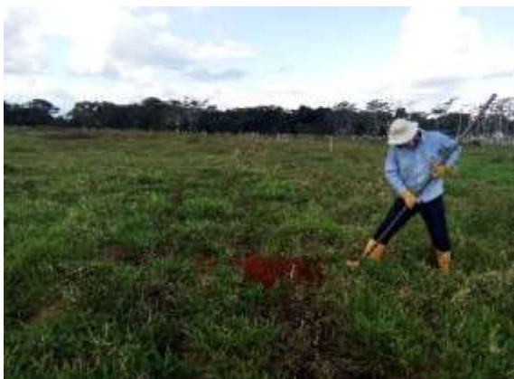
Fotografía 11 Actividades de tapado de sondeos. Torre 18.
