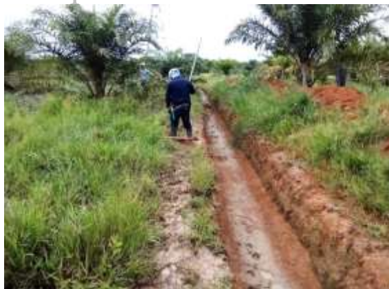
Fotografía 16 Actividades de prospección cerca de zanjado de cultivo de palma. Torre 3
