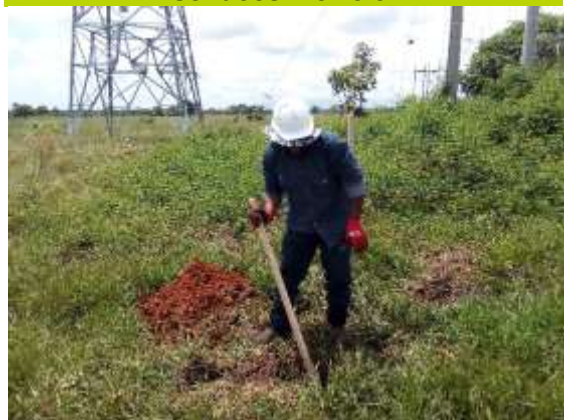
Fotografía 6 Excavación de pozos de sondeo. Torre 1.
