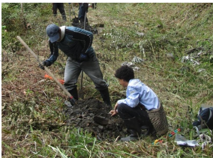
Figura 5 Proceso de excavación de pozos de sondeo
