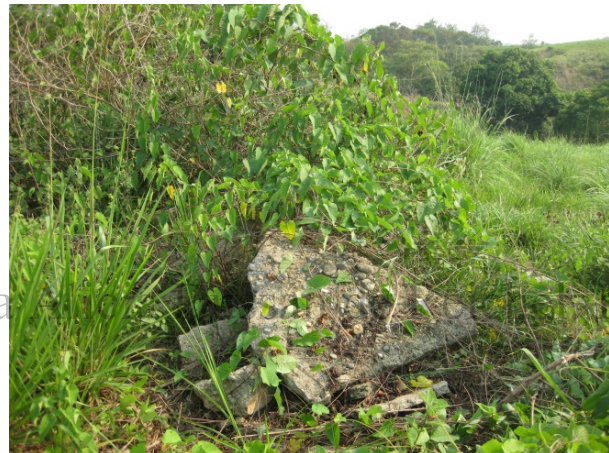
Fotografía 18. Detalle de presencia de relictos de construcción.
