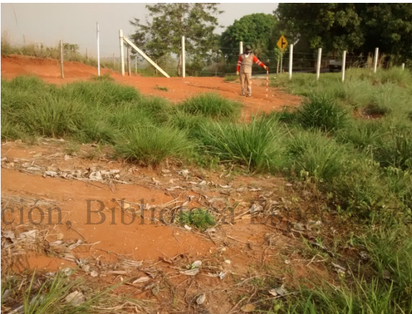
Fotografía 17. Detalle zonas erosionadas.
