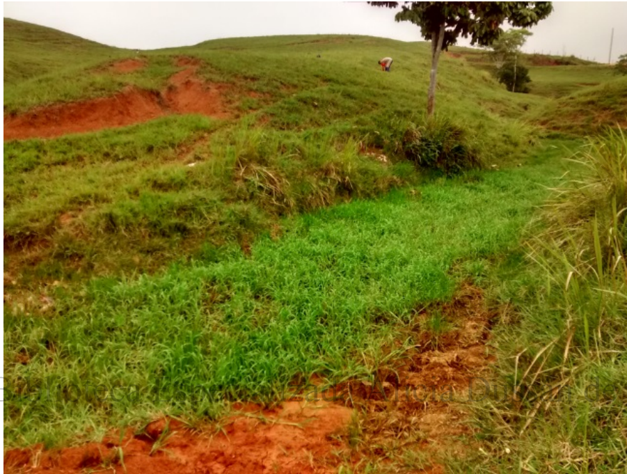
Fotografía 5. Diversos espacios identificados al interior del ZODME 33 + 250.
