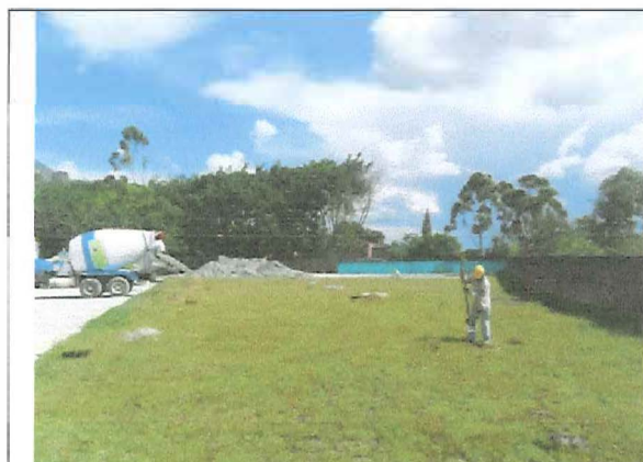
Fotografía 19. Área donde se tiene proyectado la segunda línea de cargue
