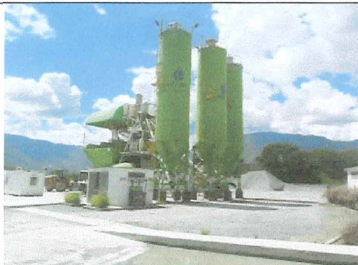
Fotografía 5. Planta Stetter, Silos y mando de planta
