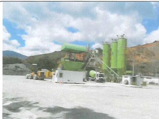
Fotografía 6. Planta Stetter, Silos y mando de planta
