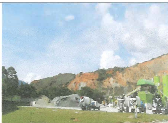
Fotografía 20. Área donde se tiene proyectado la segunda línea de cargue
