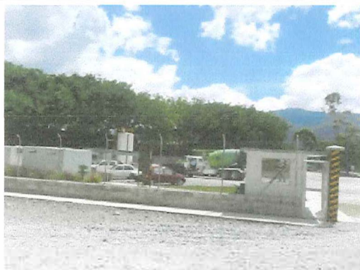
Fotografía 14. Zona de Oficinas
