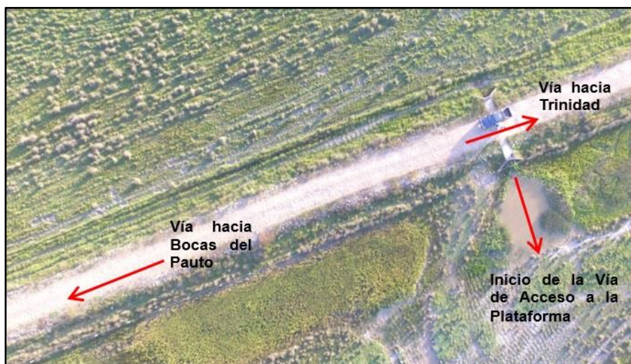
Figura 8 Inicio de la vía de acceso hacia el Pozo Exploratorio Tamariniza
