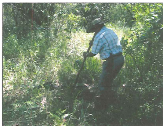
Foto 19. Apertura pozos de sondeo en sectores de Vía
