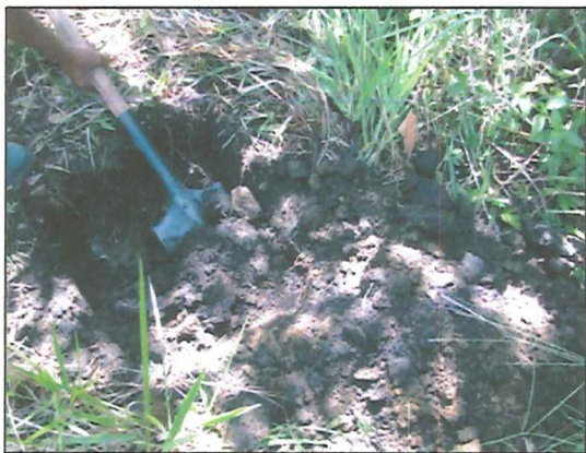
Foto 20 y 21. Apertura pozos de sondeo en UE1 Vía
