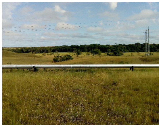
Foto 48. Línea de crudo paralela a la prospección de la línea de flujo Subtronal 1E Fase III
