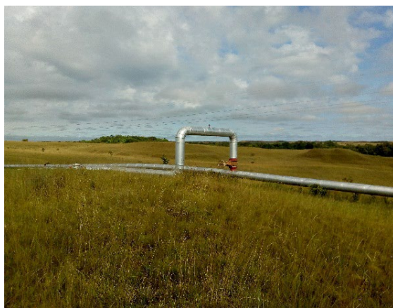
Foto 47. Línea de crudo paralela a la prospección de la línea de flujo Subtronal 1E Fase III
