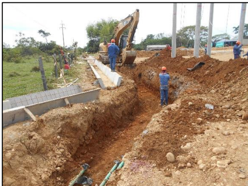
Fotografía 75 Banco de ductos sur, tramo sudoccidental. Vista al sur. Coordenadas E:1046483 N:916677,89
