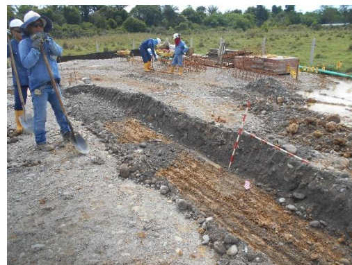
Fotografía 37 Proceso de construcción en el tramo sur, vista al sudeste. Coordenadas E:1046519,75 N:916691,05.
