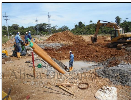
Fotografía 94 Detalle de área de conexiones entre tubería de proceso y múltiple, área en proceso de relleno. Vista noroeste. Coordenadas E:1046440,79 N:916728,24
