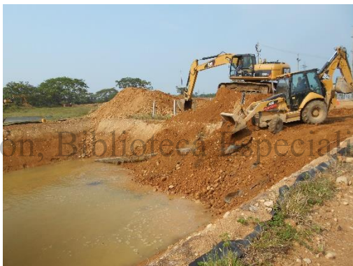
Fotografía 51 Proceso de deposición de rellenos en el costado sur de la piscina artificial, vista sudoeste. Coordenadas E: 1046445,46 N: 916607,89
