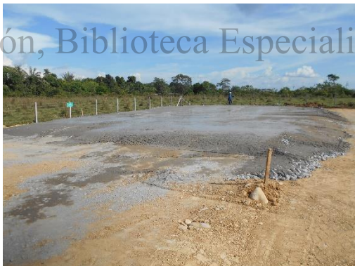
Fotografía 59 Futuro campamento para el equipo mecánico, sector sudeste, vista al sudeste. E:1046414,82 N:916643,7
