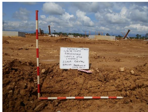
Fotografía 54 Detalle de rellenos R1 en el centro. Coordenadas E:1046497,30 N:916712,63
