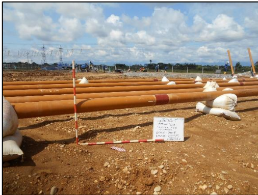
Fotografía 89 Tubería de proceso durante la fase de soldadura. Vista noroeste. Coordenadas E:1046432,41 N:916705,11
