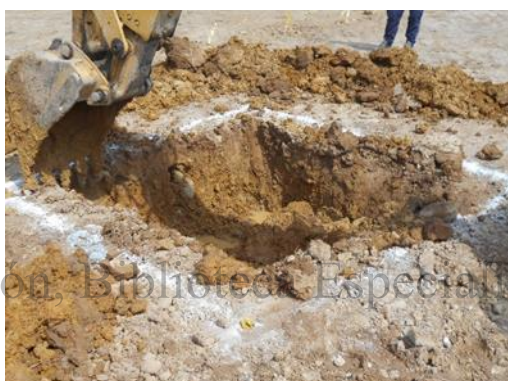
Fotografía 28 Delimitación del contrapozo no. 1. Vista hacia el norte. Coordenadas E:1046480,38 N:916707,51
