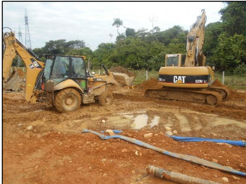
Fotografía 46 Área de construcción del desarenador. Proceso de relleno, vista hacia el norte. Coordenadas E:1046486,55 N:916744,75.
