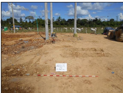
Fotografía 87 Torre R4 oeste, en proceso de construcción. Vista oeste. Coordenadas E:1046457,07 N:916647,95.
