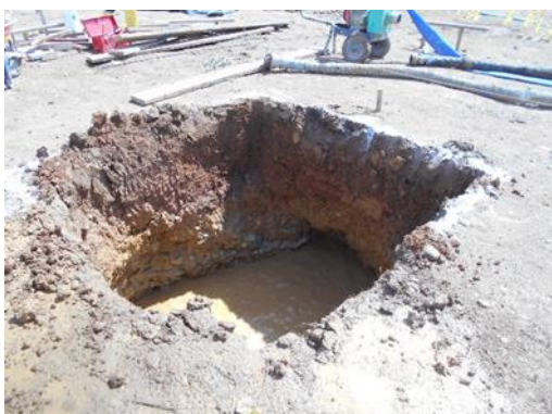
Fotografía 26 Ejemplo de excavación prismática, realizada por excavadora en el contrapozo no. 6. Coordenadas E:1046475,86 N:916757,30
