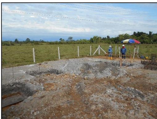
Fotografía 95 Área del múltiple, segunda fase de relleno, vista noroeste. Coordenadas E:1046398,67 N:916715,15
