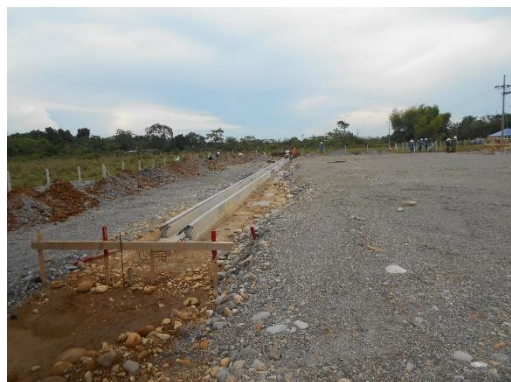
Fotografía 36 Cunetas aceitosas en proceso de construcción, tramo este, vista al sur. Coordenadas E:1046503,61 N:91679,94 .
