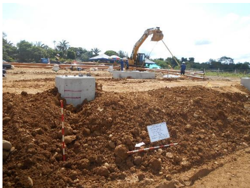
Fotografía 53 Detalle de relleno en la línea de contrapozos este, vista sudeste
