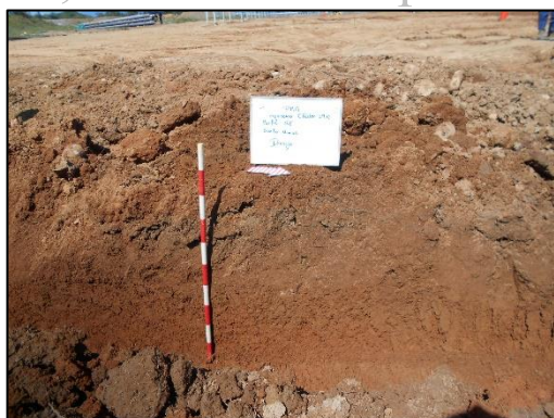
Fotografía 61 Perfil de una de las zanjas de la puesta a tierra. Vista este. Coordenadas: E:1046401,71 N:916670,23
