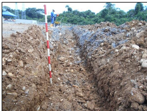
Fotografía 65 Detalle circuito este, vista noroeste. Coordenadas: E:1046468,88 N:916765,61.
