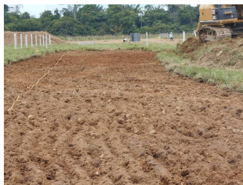
Fotografía 98 Vía de acceso con detalle a decámetro, marcando 50m. Vista al este. Coordenadas E:1046348,16 N:916682,14.
