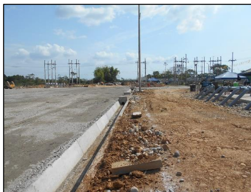
Fotografía 96 Múltiple finalizado. Vista al sur. Coordenadas E:1046403,88 N:916735,24
