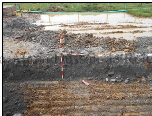
Fotografía 35 Excavación de cunetas aceitosas en el tramo norte, vista al oeste. Detalle de relleno artificial. Coordenadas E:1046504,14 N:916715,72.
