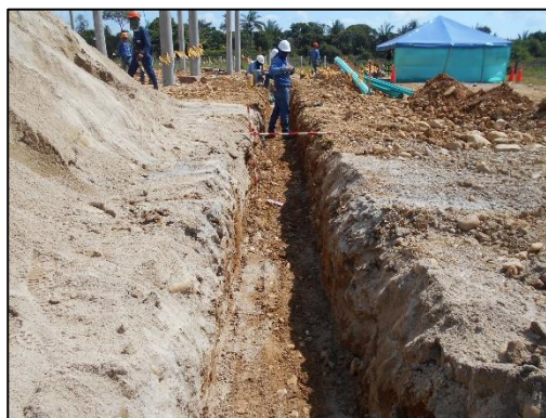
Fotografía 86 Zanja para tendido de cableado, alimentación para iluminación periférica. Coordenadas E:1046412,13 N:916640,90.
