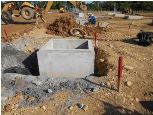
Fotografía 32 Instalación caja de bombeo para el contrapozo no. 12, vista norte. Coordenadas E:1046445,21 N:916705,69
