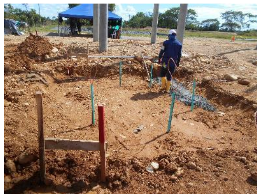
Fotografía 13 Corte para transformador, área sudoeste. Coordenadas E: 1046460,07 N: 91664,83.
