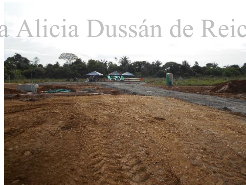
Fotografía 60 Campamento civil, visto hacia el norte. Coordenadas E: 1046499,58 N: 916756,28
