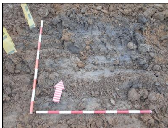
Fotografía 104 Detalle de suelo arcilloso oliva durante la excavación de cunetas pluviales en el sector norte. Coordenadas E:1046446,23 N:916798,03
