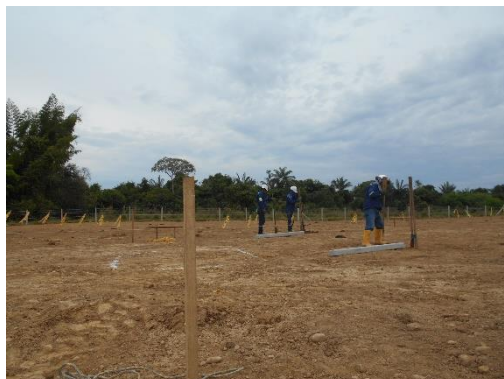
Fotografía 50 Proceso de instalación de dos postes en lo que se convertirá en la plataforma de perforación, día 12 de septiembre. Vista al este. Coordenadas E: 1046487,22 N: 916708,06.
