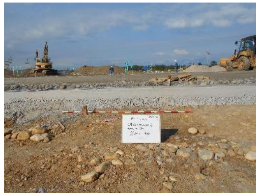
Fotografía 11 Proceso de relleno en el área centro. Detalle de acopios de R1 y R2 listos para ser depositados. Coordenadas E: 1046466,21 N: 916731,19
