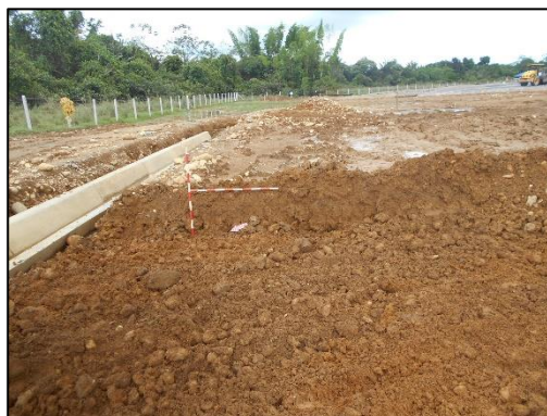
Fotografía 45 Nivelación del sector noroeste. Detalle de perfil dejado por la excavación de casi 0,5m de profundidad. Vista este. Coordenadas E:1046418,79 N:916802,31
