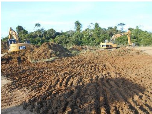
Fotografía 8 Descapote. Vista desde centro hacia el norte. Coordenadas E: 1046468,25 N: 916756,18.
