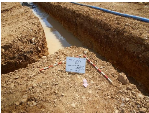
Fotografía 91 Bifurcación en excavación para codo de tubería de proceso para alimentación de contrapozo. Vista sur. Coordenadas E:1046462,10 N:916723,27
