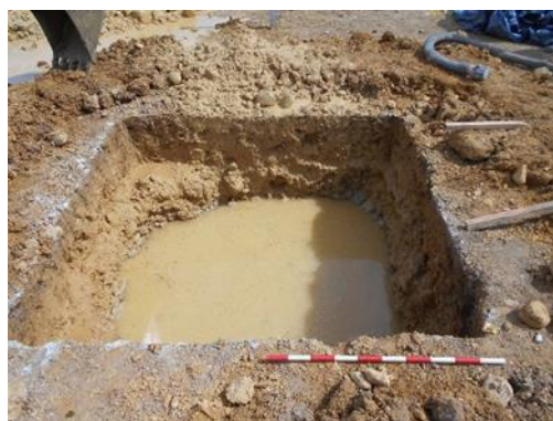
Fotografía 27 Contrapozo no. 2 en la segunda fase de excavación. Coordenadas E:1046479,48 N:916717,47
