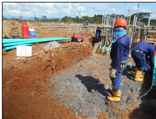
Fotografía 80 Proceso de aislamiento para el Pull point B, vista hacia el oeste. Coordenadas E:1046440,69 N:916668,24
