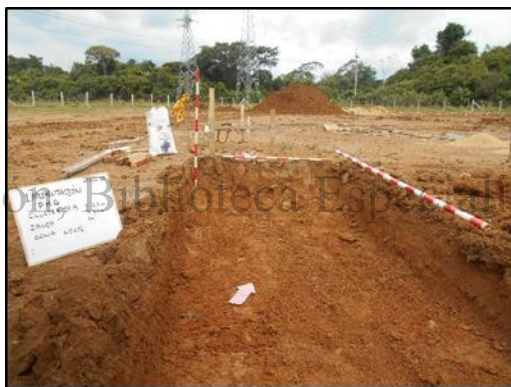
Fotografía 34 Excavación de cunetas aceitosas, tramo oeste, vista norte. Coordenadas E:1046425,98 N:91647,91
