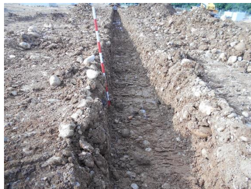
Fotografía 68 Detalle circuito centro, vista norte. Coordenadas: E:1046452,80 N:916729,64.
