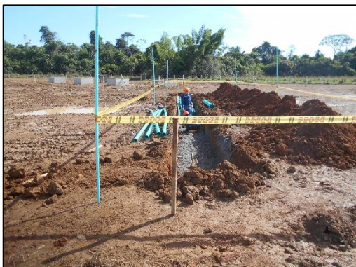
Fotografía 71 Tramo este del banco de ductos, vista al norte. Coordenadas E:1046461,36 N:916687,13
