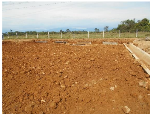
Fotografía 41 Esquina noroeste, donde se encuentran el tramo 1 y el 3. Proceso de nivelación, vista oeste. Coordenadas E:1046427,18 N:916811,43.
