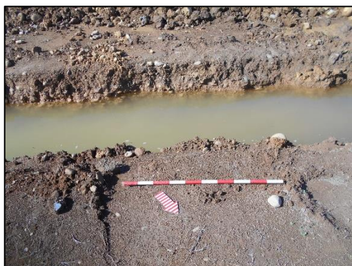
Fotografía 38 Primer tramo siendo excavado, vista centro. Coordenadas E:1046431,53 N:916806,13
