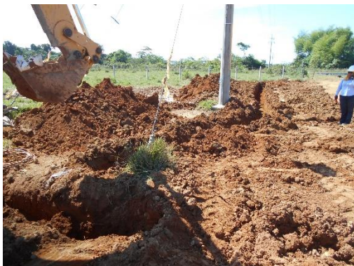
Fotografía 63 Última línea de la excavación, cerca de un poste preexistente. Coordenadas: E:1046449,16 N:916654,01
