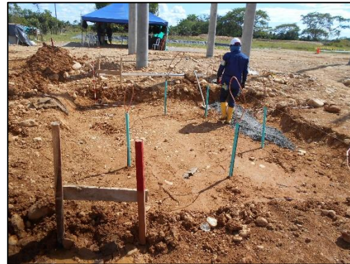
Fotografía 82 Excavación para transformador SDT-2, sobre relleno. Vista oeste. Coordenadas E:1046458,98 N:916653,16.
