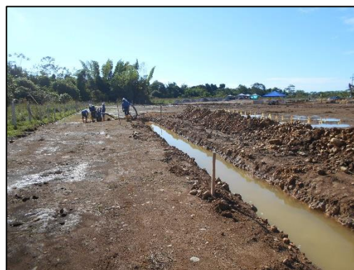
Fotografía 39 Tramo noreste del circuito de cunetas pluviales, vista sudeste. Coordenadas E:1046464,10 N:916787,39
