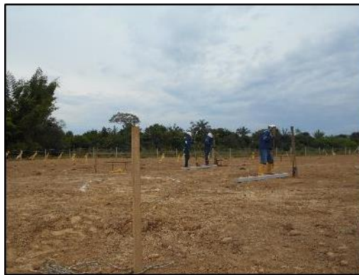
Fotografía 16 Cercado para plataforma de contrapozos, sector este. Coordenadas E: 1046487,22 N: 916708,06.
