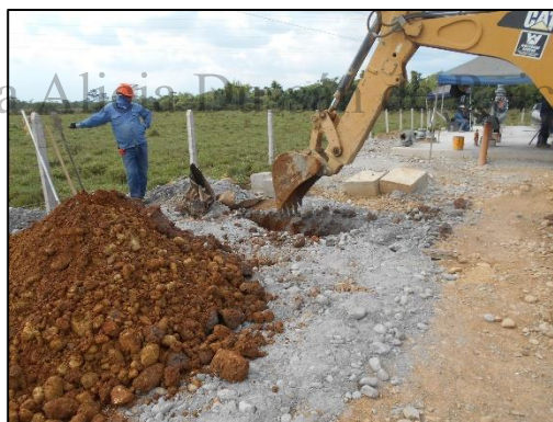
Fotografía 88 Excavación para poste en el marten oeste, vista noroeste. Coordenadas E:1046406,84 N:916745,49
