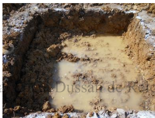
Fotografía 29 Detalle del contrapozo no. 1, en proceso de inundación. Coordenadas E:1046480,38 N:916707,51
