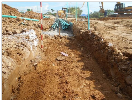
Fotografía 72 Banco de ductos este, tramo conectivo con el pullpoit este. Vista al oeste. Coordenadas E:1046473,73 N:916696,69.
