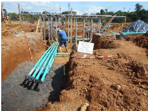
Fotografía 77 Pull point A (Centro). En proceso de instalación, vista al norte. Coordenadas E:1046454,33 N:916665,86.
