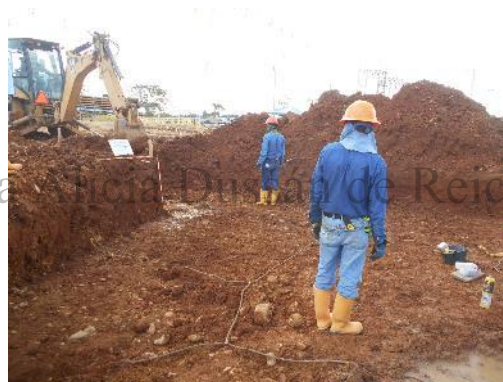
Fotografía 15 Pull point B, visto hacia el noreste. Coordenadas E: 1046457,73 N: 916665,31.
