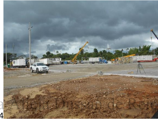
Fotografía 4 Área final intervenida y funcionamiento del clúster 19A a Enero de 2018.
