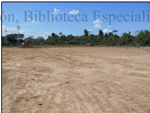
Fotografía 24 Detalle del acopio norte (final), vista Noreste. Coordenadas E: 1046451,29 N: 916779,02.
