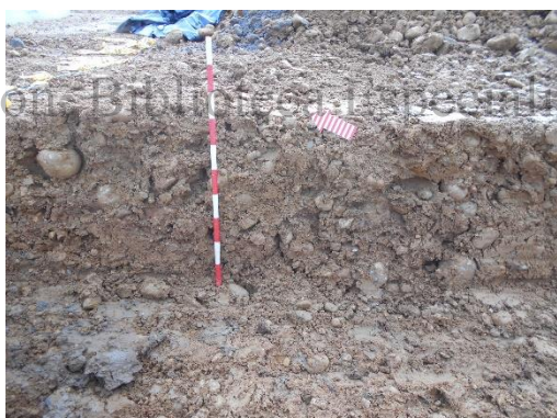
Fotografía 73 Banco de ductos, línea centro. Detalle de suelo de relleno compensado. Vista al este. Coordenadas E:1046441,84 N:916736,01
