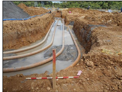
Fotografía 90 Tubería de proceso siendo instalada, línea este. Vista norte. Coordenadas E:1046463,56 N:916692,03.
