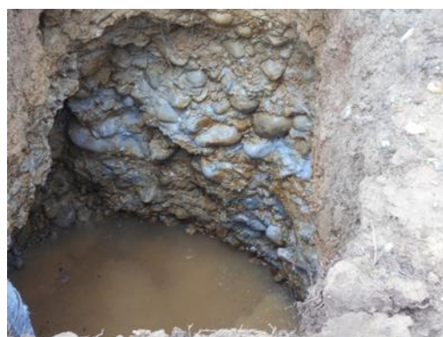
Fotografía 31 Detalle de excavación de zanja para el contrapozo no. 5. Coordenadas E: 1046475,86 N:916757,30.
