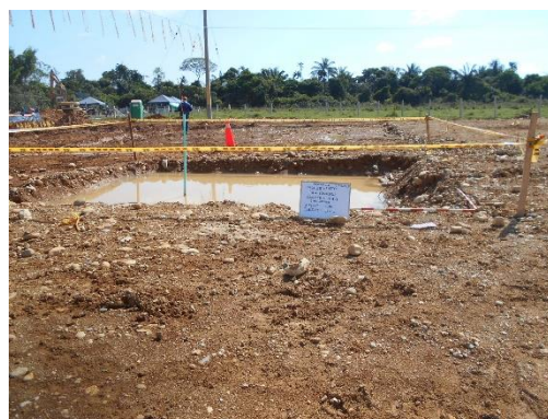
Fotografía 84 Excavación para transformador del nuevo banco de ductos. Vista al sur. Coordenadas E:1046412,39 N:916648,31
