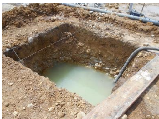
Fotografía 30 Detalle de excavación para el contrapozo no. 2, mientras es drenado. Se observa la capa de cantos rodados. Coordenadas E:1046479,48 N:916717,47
