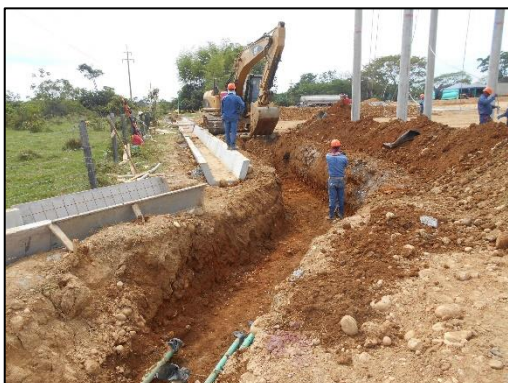
Fotografía 44 Detalle de excavación de banco de ductos en el sector sur. Se aprecia la extensión del circuito de aguas pluviales dispuesto sobre el nivel natural del suelo a la izquierda. Coordenadas E:1046479,70 N:916678,34
