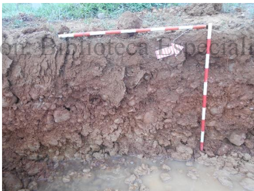
Fotografía 42 Perfil en tramo 3, vista oeste. Detalle de inundación. Coordenadas E:1046413,37 N:916805,15.
