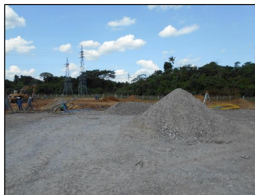
Fotografía 56 Ejemplo de acopio tipo R1, sector central, vista noroeste. E:1046447,48 N:916722,03
