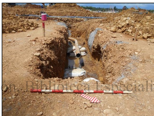
Fotografía 93 Detalle de elevación de una tubería de proceso al llegar a la superficie, vista sudoeste. Coordenadas E:1046403,49 N:916717,46.
