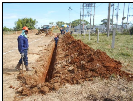
Fotografía 62 Primera zanja realizada en el clúster, orientada de norte a sur. Vista norte. Coordenadas: E:1046428.81 N:916652,39
