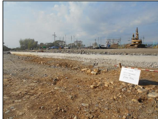
Fotografía 47 Área de construcción del skimmer no.2. Detalle en diferentes estratos de relleno artificial, vista al sudoeste. Coordenadas E:1046489,28 N:916711,97
