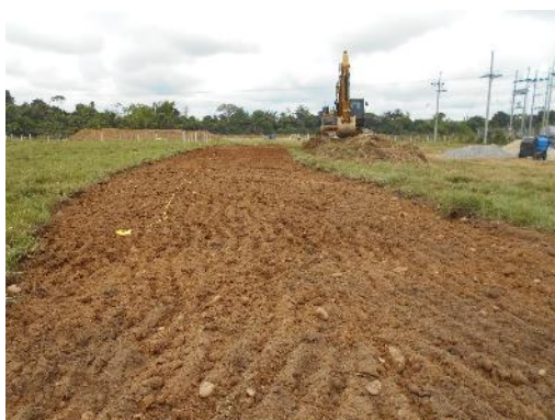
Fotografía 97 Vía de acceso en tramo descapotado, vista al este. Coordenadas E:1046366,70 N:916685,38.
