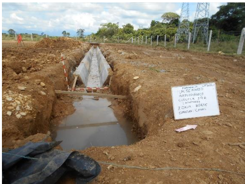
Fotografía 40 Tramo noreste durante el proceso de construcción, vista sudoeste. Coordenadas E:1046420,93 N:916809,16
