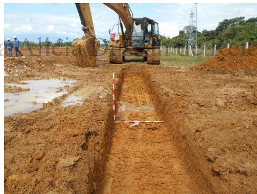
Fotografía 43 Tramo 2, sector noreste. Detalle de pendiente en excavación. Vista oeste. Coordenadas E:1046490,16 N:916772,21
