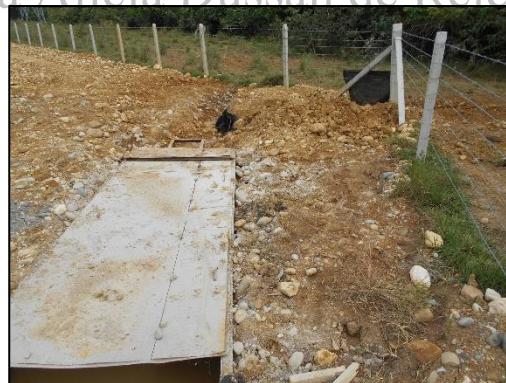
Fotografía 49 Excavación de desarenador en la esquina noreste, vista al norte. Detalle de material de relleno. E: 1046510,25 N:916770,64
