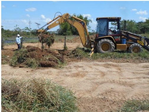
Fotografía 22 Descapote del área meridional, vista sur. Se aprecia la piscina de lodos preexistente, y el cercado antiguo (Clúster 19). Coordenadas: E: 1046451,3 N: 91661,18.
