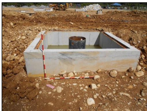
Fotografía 55 Detalle de relleno en contrapozo no. 4. Vista al este. Coordenadas E:1046477,67 N:916737,39
