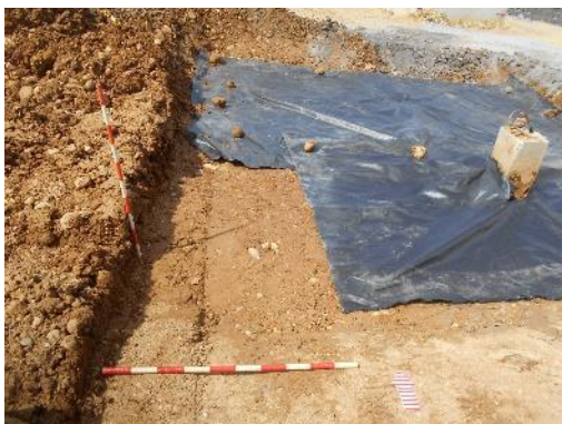
Fotografía 12 Corte para aislamiento de zona de control eléctrico. Zona este. Coordenadas E: 1046467,21 N: 91673,36.
