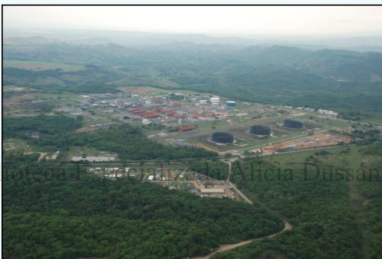
Vista área CPF Cusiana. En la esquina derecha área en donde se construirá el llenadero de carga GLP.
