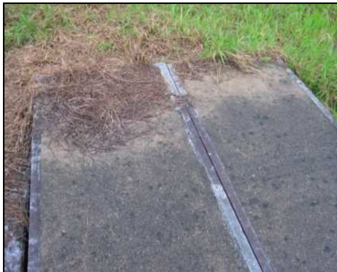
FOTOGRAFÍA 5 PLACA QUE CUBRE LA TUBERÍA DEL ACUEDUCTO
