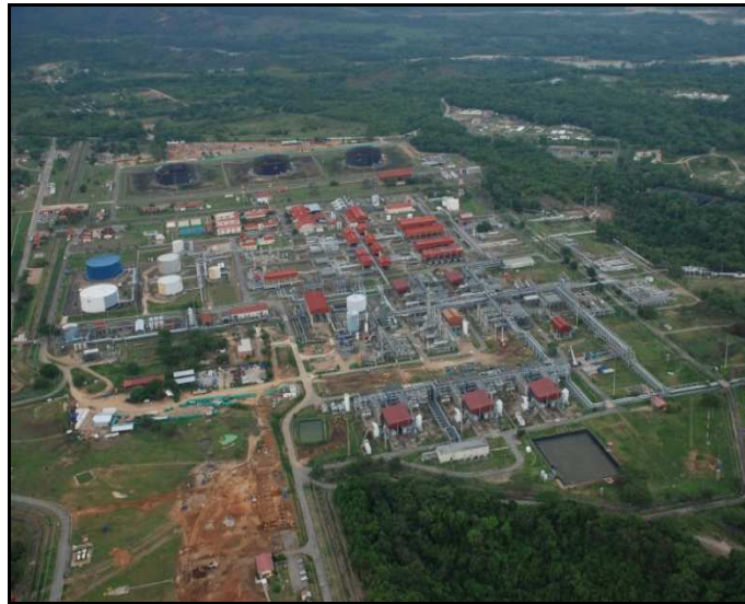
FOTOGRAFÍA 4 VISTA ÁREA DEL CPF CUSIANA. AL FONDO FUTURA ÁREA DE LLENADERO DE CARGA GLP
