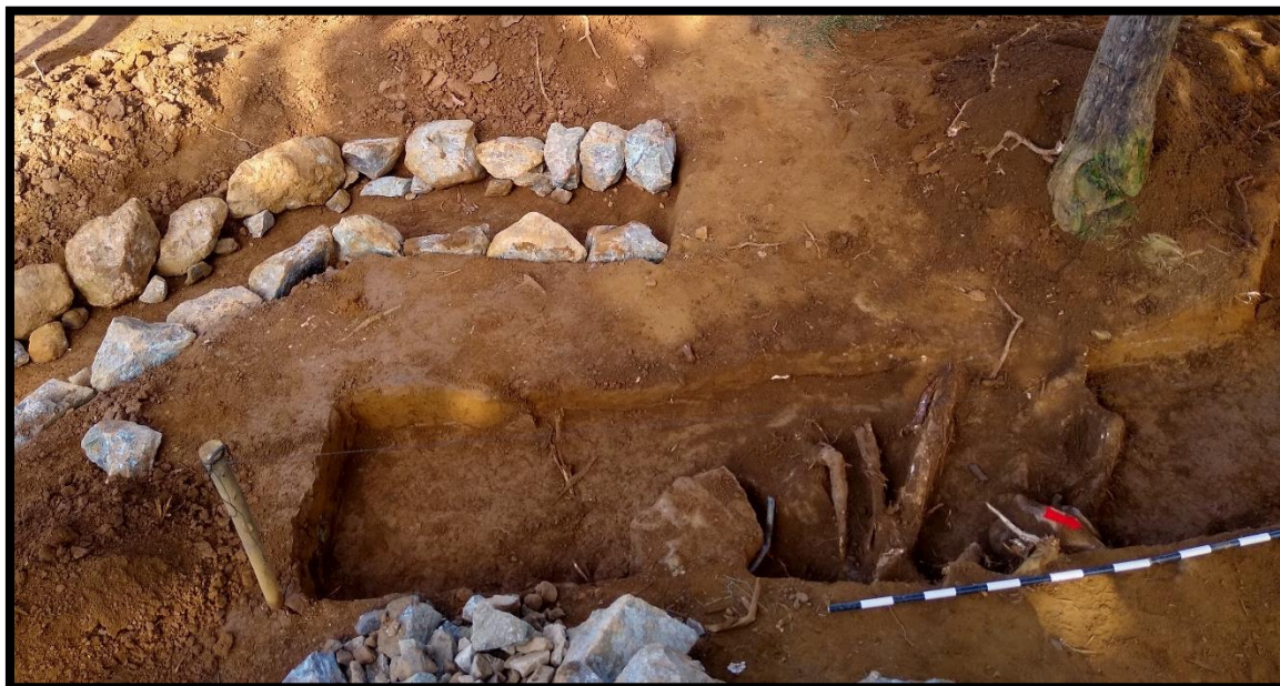
Digitalización, Biblioteca Especializada Alicia Dussán de Reichel. ICANH Foto 9. Detalle del proceso de construcción de la base del vallado.
