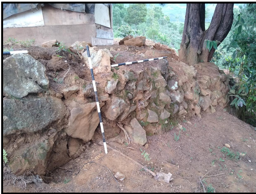
Foto 31. Punto dos. Vallado en piedra (Rasgo 1).
