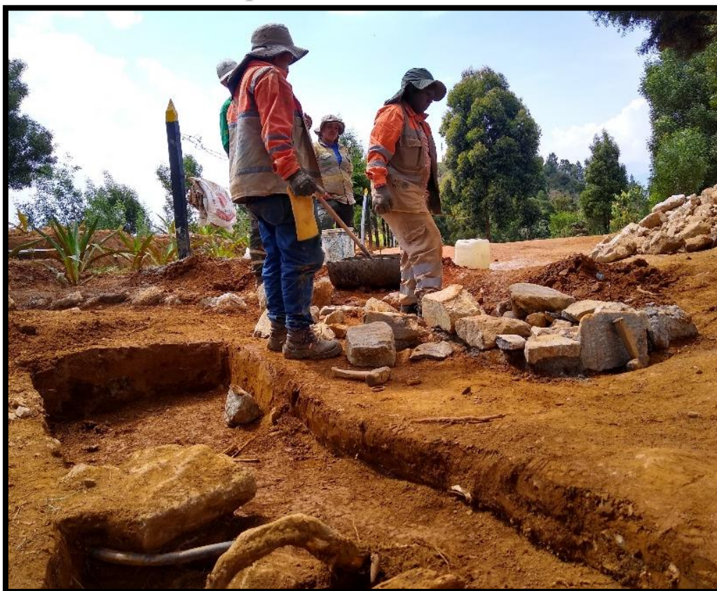
Foto 10. Registro de la construcción de los cimientos del Vallado en piedra.
