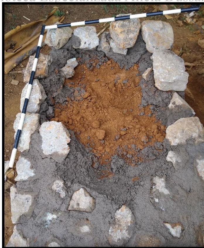
Foto 14. Detalle del proceso de estructuración final del cuerpo del vallado.
