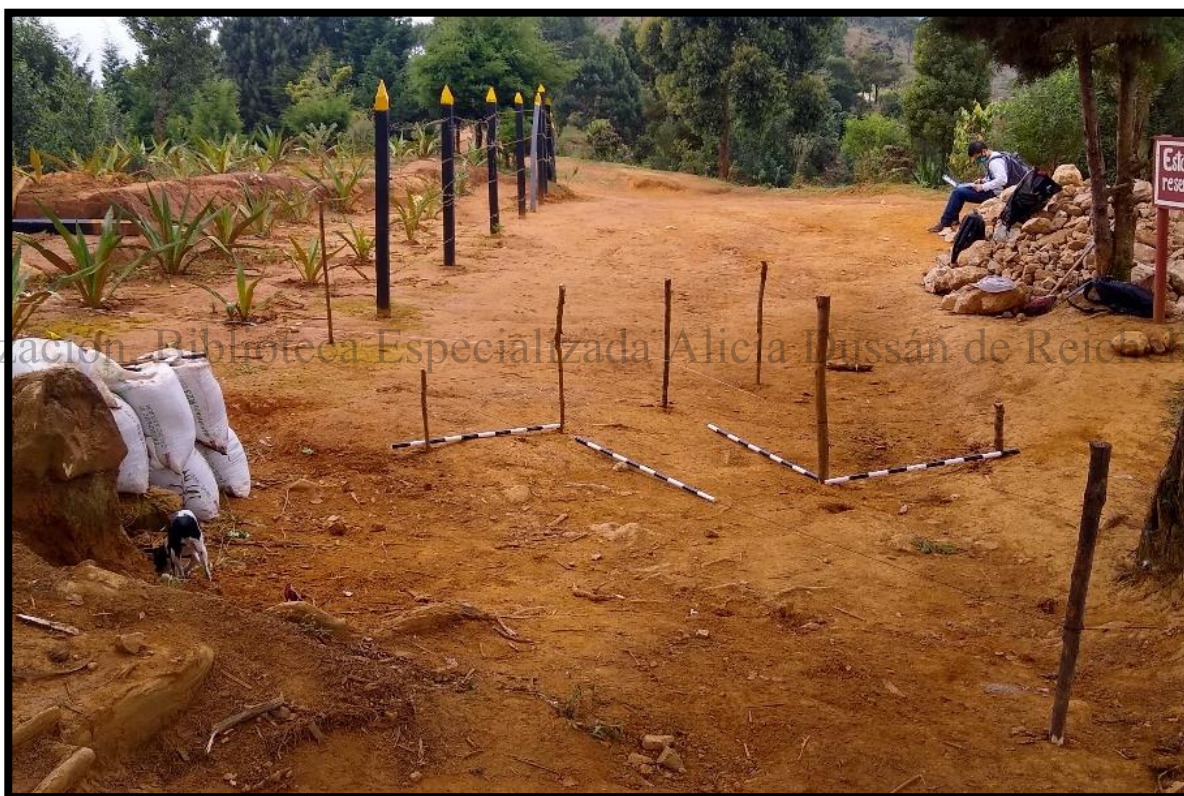
Foto 4. Estado inicial del terreno y diseño de los vallados en piedra propuestos.
