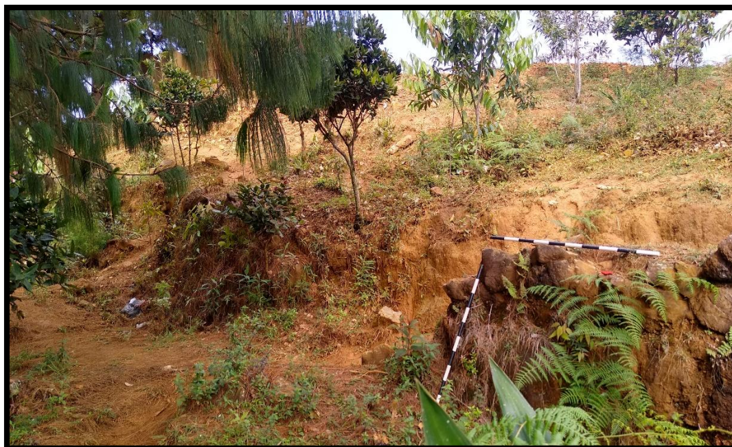
Foto 33. Tramo perdido entre punto dos del registro y el punto tres (Rasgo 1).
