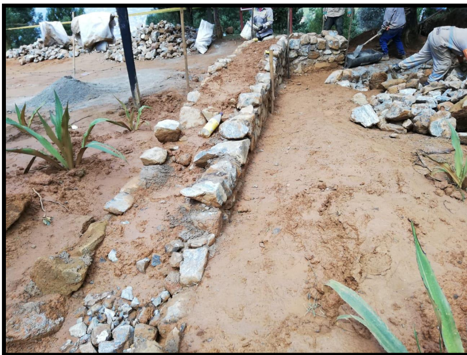
Foto 12. Registro del proceso de la construcción del vallado número dos.
