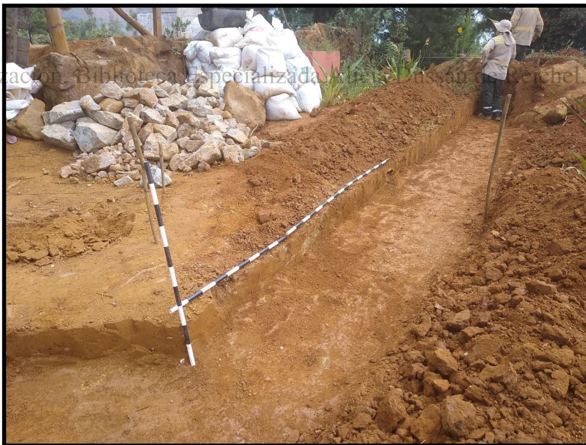
Foto 6. Profundidad final de la excavación para el vallado 2.
