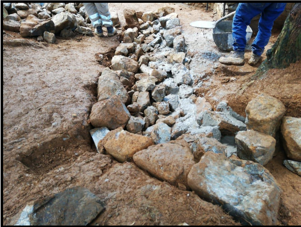
Foto 11. Registro de la construcción de los cimientos del Vallado en piedra.
