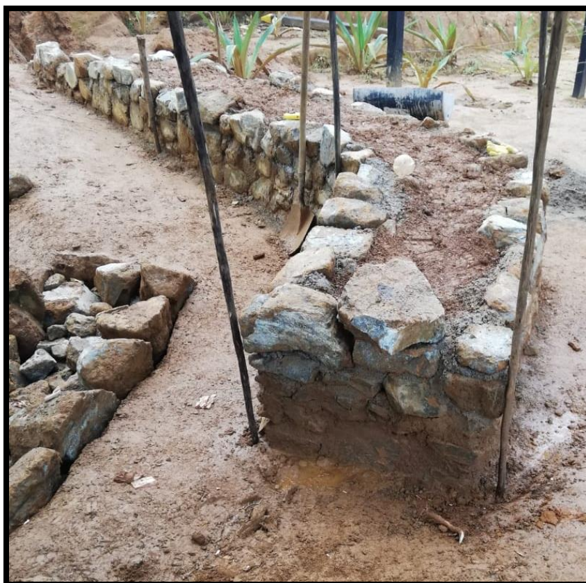
Foto 13. Registro del proceso de la construcción del vallado número dos.
