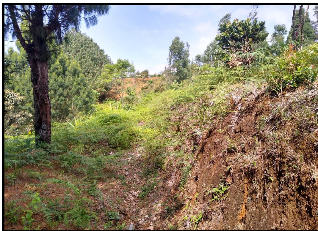
Foto 34. Tramo perdido del vallado entre punto tres y punto cuatro del registro (Rasgo 1).
