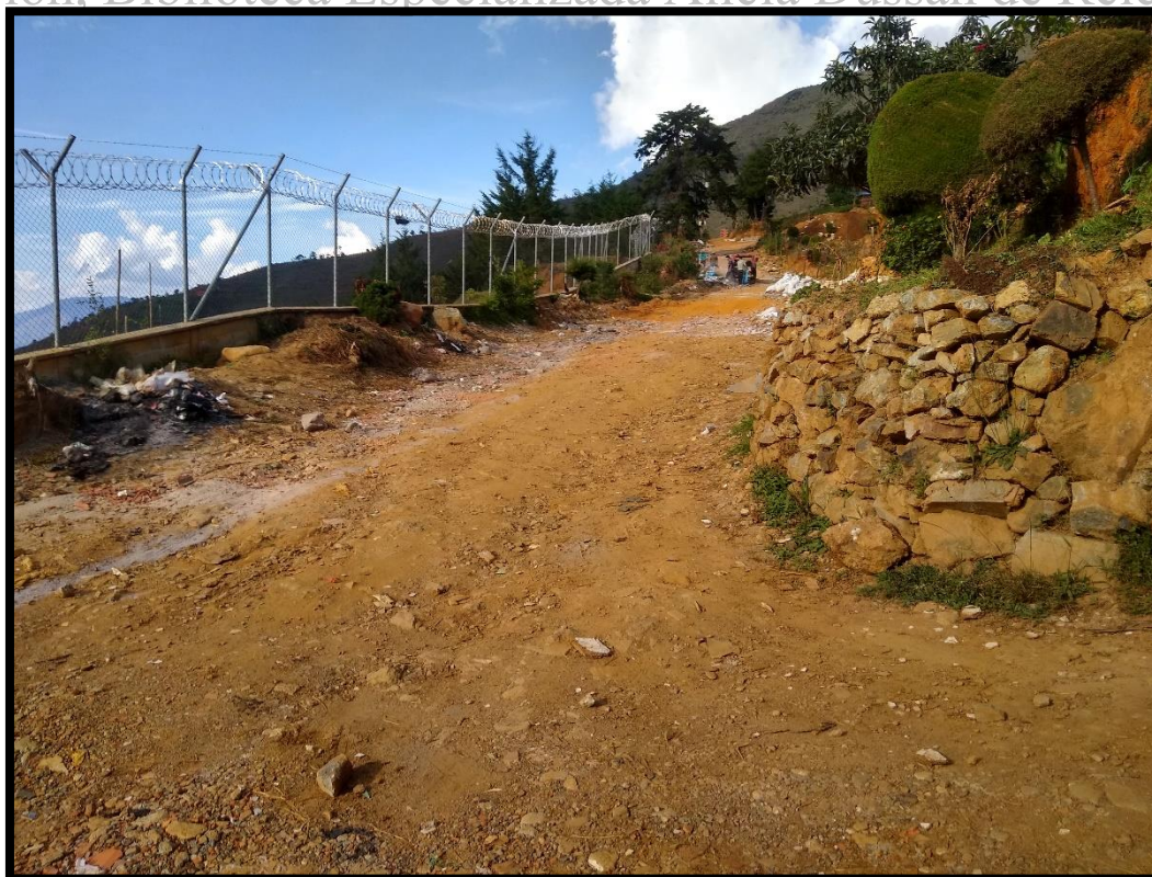
Foto 43. Detalle del estado de conservación del Camino de La cuesta.
