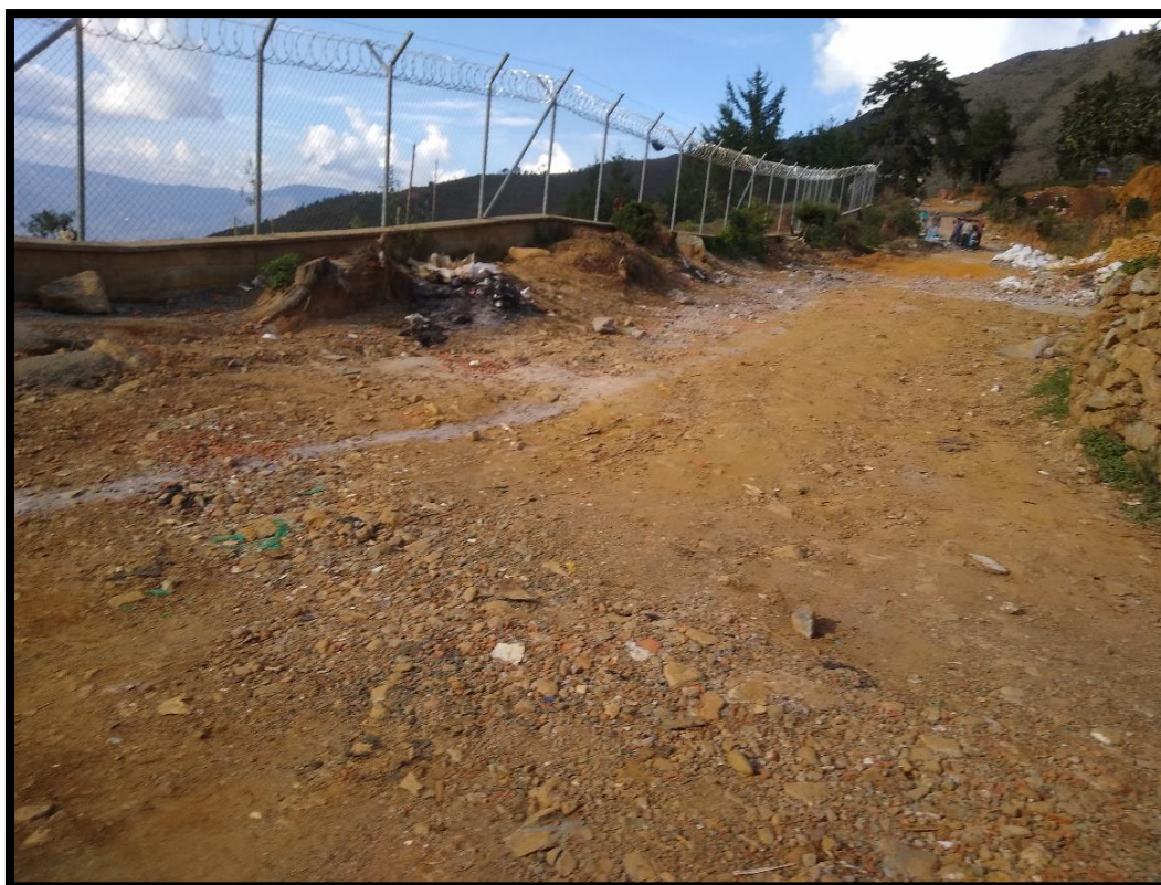
Foto 42. Detalle del estado de conservación del Camino de La cuesta.
