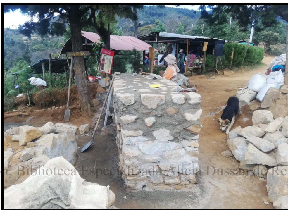
Foto 15. Detalle del proceso de “rebitado” en las ranuras que se forman entre la unión de las rocas.
