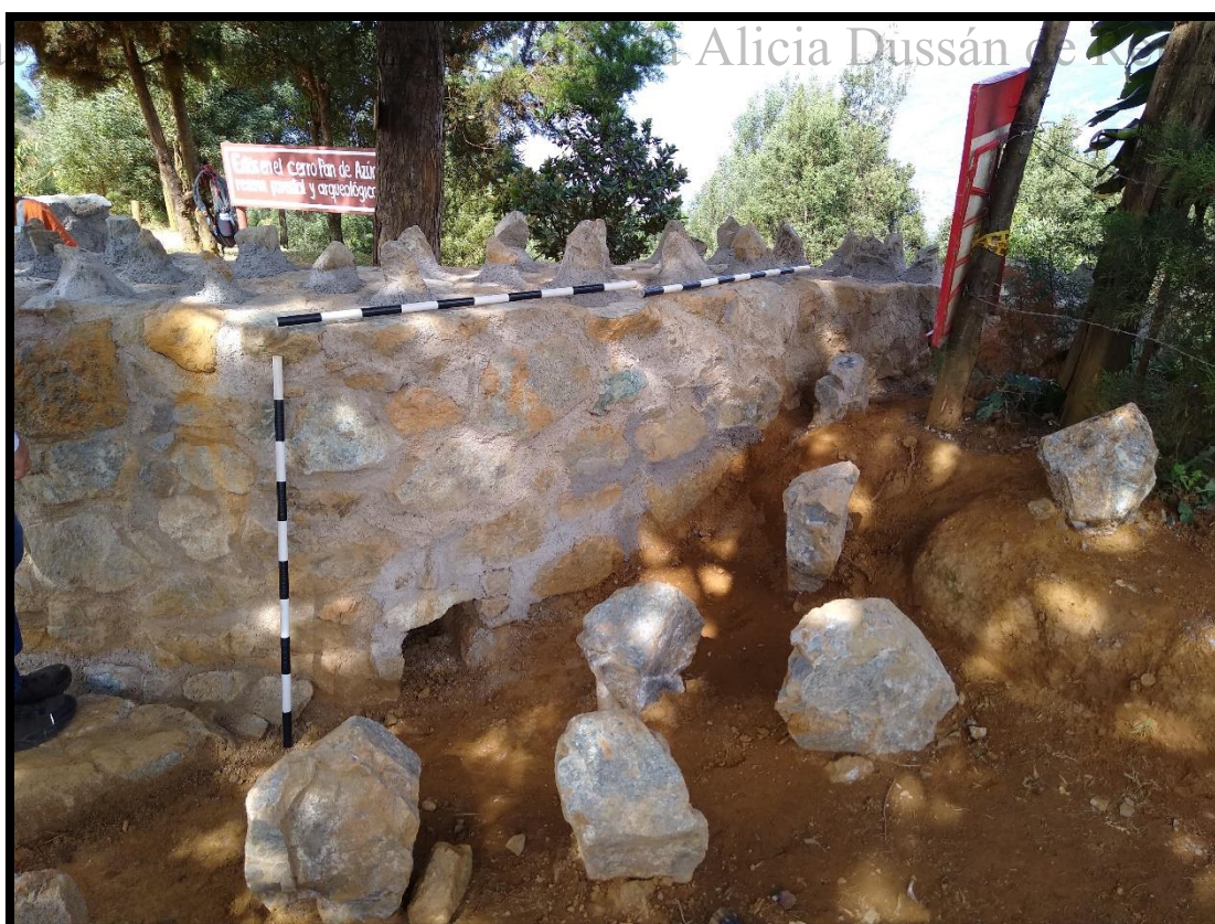
Foto 22. Detalle de disipadores y canales para el manejo de agua.
