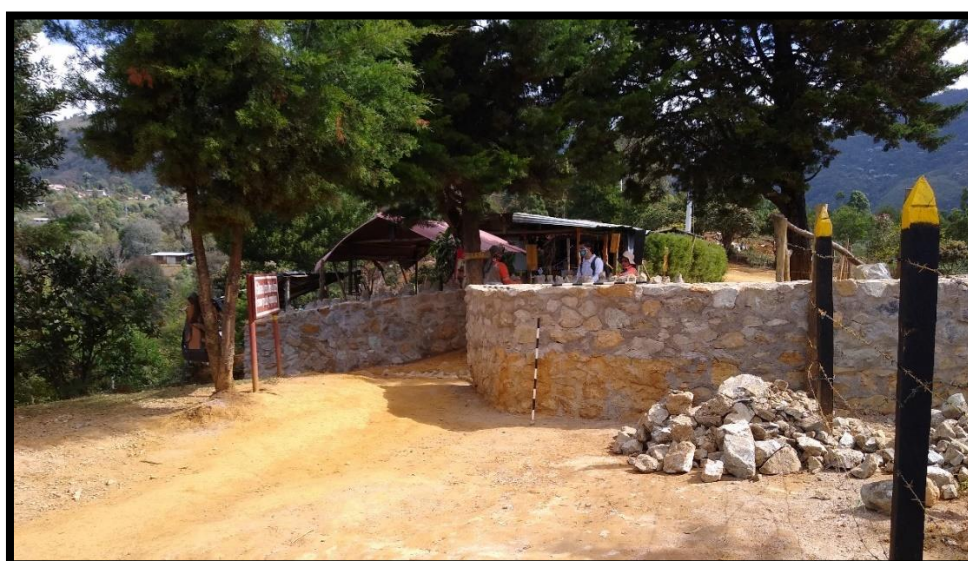
Foto 16. Estado final del vallado, vista sur-norte.
