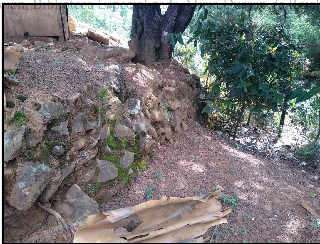
Foto 32. Punto dos. Vallado en piedra (Rasgo 1).
