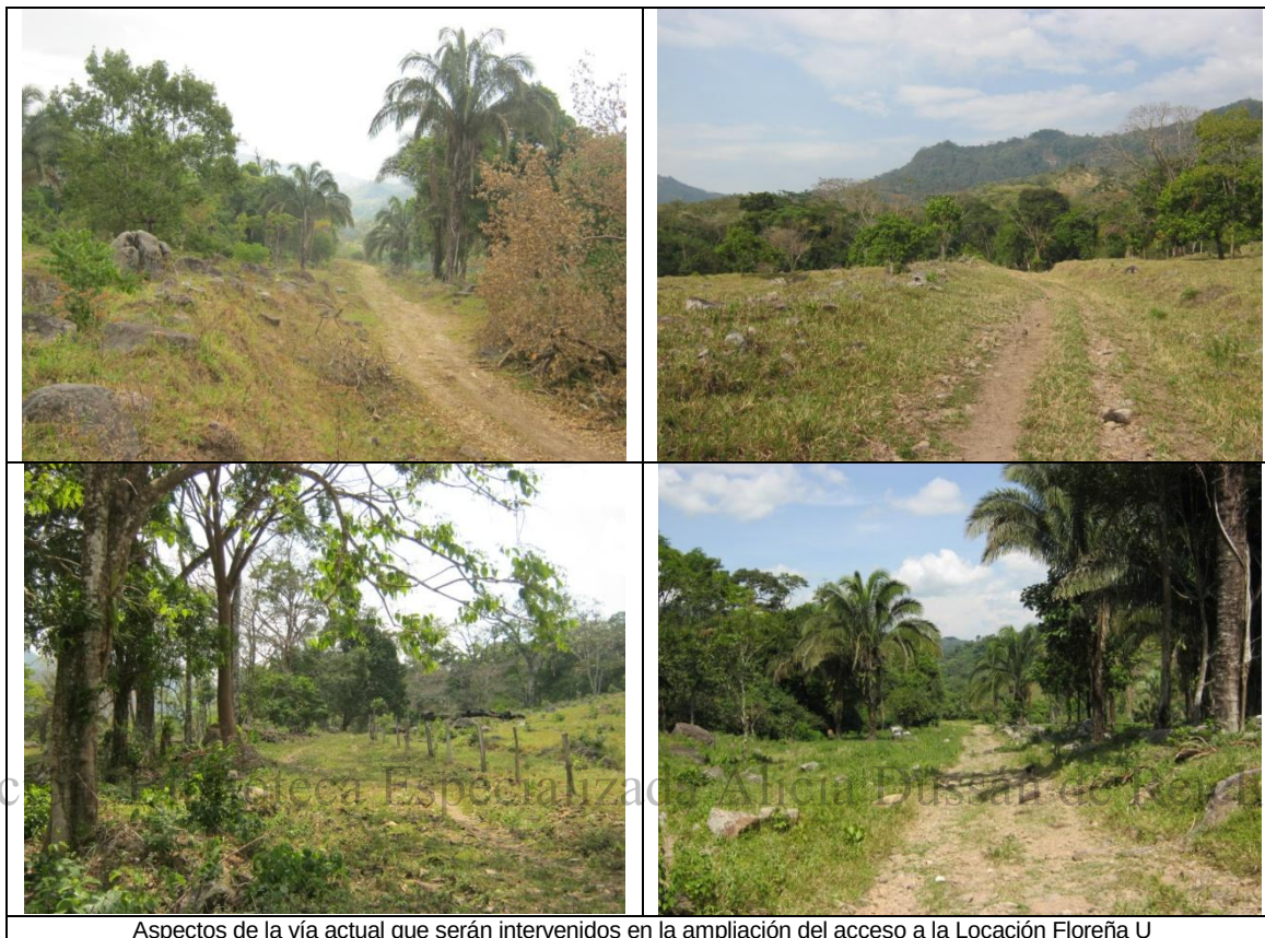
Aspectos de la vía actual que serán intervenidos en la ampliación del acceso a la Locación Floreña U
