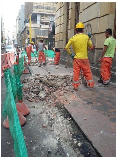
Figura 17. Actividades de levantamiento de pisos, carrera 8 entre Av. Jiménez y Calle 12C, costado oriental.
