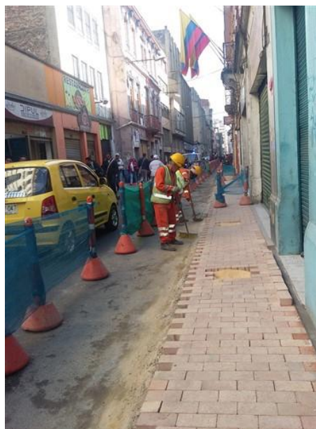
Figuras 37a y 37b. Instalación de nuevo piso en adoquín en la carrera 9, entre calles 12 y 12B, costado oriental
