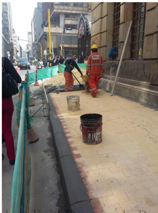
Figura 21. Fundición de placa de concreto en la carrera 8 entre Av. Jiménez y calle 12C, costado oriental.
