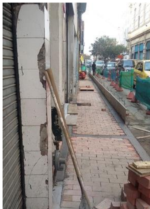
Figura 44. Instalación de adoquines y fundición de vigas carrera 9 entre calles 12 y 12B, costado occidental.
