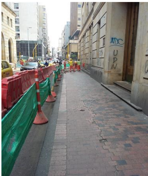
Figura 16. Inicio de remoción de adoquín en la carrera 8, entre Av. Jiménez y Calle 12C, costado oriental.
