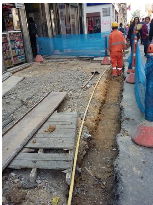
Figura 26. Relleno en arena y mortero y tuberías de gas asociadas. Carrera 9 entre calle 12 y 12B, costado oriental.
