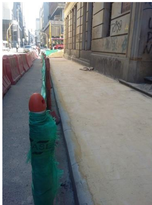
Figuras 22a y 22b. Finalización de fundición de placa de concreto e instalación de adoquines en la carrera 8 entre Av. Jiménez y calle 12C, costado oriental.
