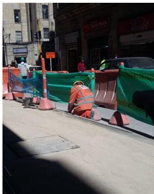
Figura 51. Instalación de vigas y adoquines en la calle 12b entre carreras 8a y 9 costado sur.
