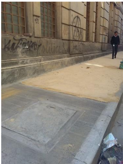
Figuras 22a y 22b. Finalización de fundición de placa de concreto e instalación de adoquines en la carrera 8 entre Av. Jiménez y calle 12C, costado oriental.
