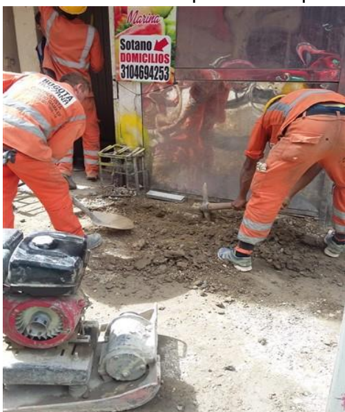
Figura 50. Remoción de pisos en la calle 12b entre carreras 8a y 9 costado sur
