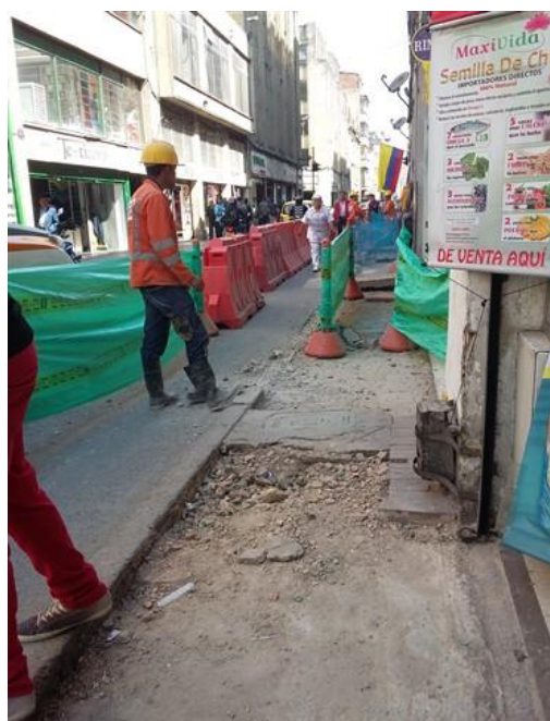
Figura 27. Demolición de vigas y presencia de placas de concreto discontinuas. Carrera 9 entre calle 12 y 12B costado oriental.
