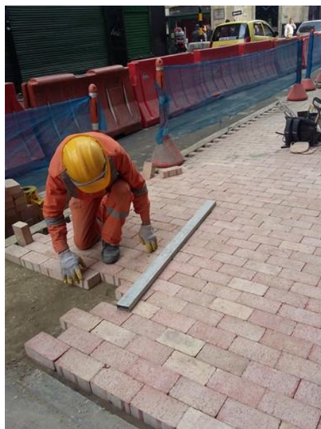
Figuras 37a y 37b. Instalación de nuevo piso en adoquín en la carrera 9, entre calles 12 y 12B, costado oriental
