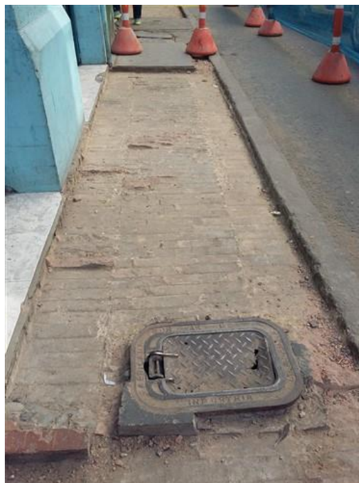
Figura 30. Capa de adoquín bajo la primera capa retirada, asociada a los contadores del acueducto. Carrera 9 entre calle 12 y 12B, costado oriental.
