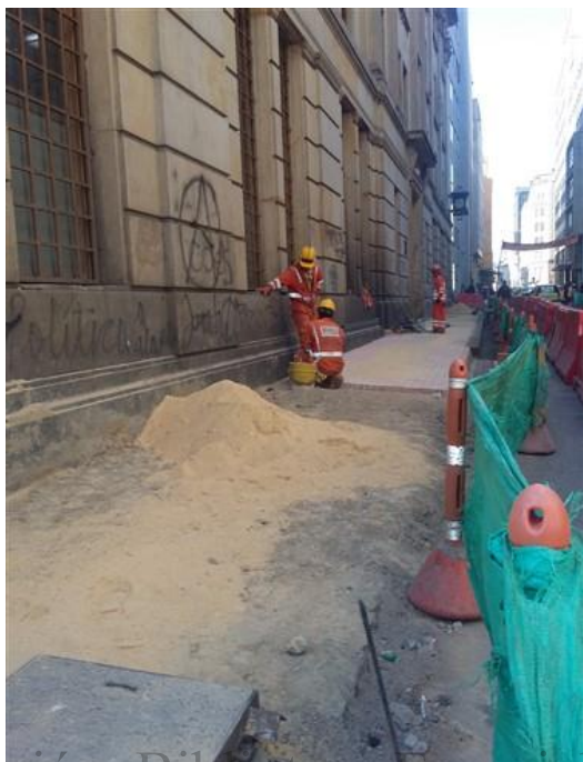
Figura 20. Instalación de adoquín en la carrera 8 entre Av. Jiménez y calle 12C, costado oriental.
