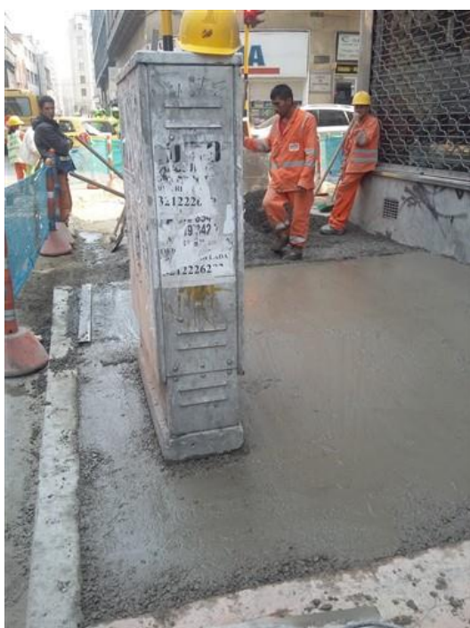
Figura 43. Proceso de fundición de concreto en la carrera 9 entre calles 12 y 12B, costado occidental.
