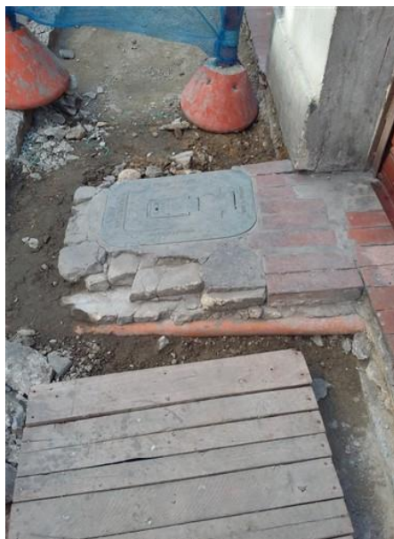
Figura 28. Capas de adoquín retirado, placa de concreto subsiguiente, tubería de PVC y suelo de arena y mortero junto a un contador del agua. Carrera 9 entre calle 12 y 12B costado oriental.
