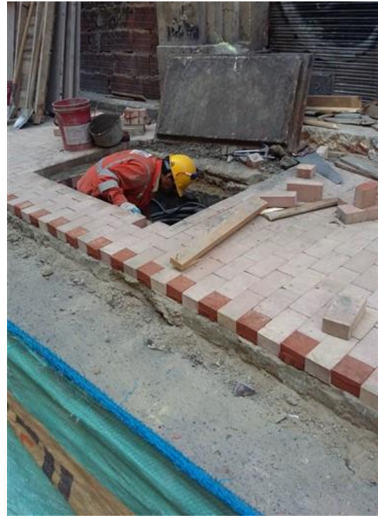
Figura 14. Adecuación de cajas de cableado telefónico durante la instalación de pisos. Carrera 8 entre Av. Jiménez y calle 12C, costado occidental
