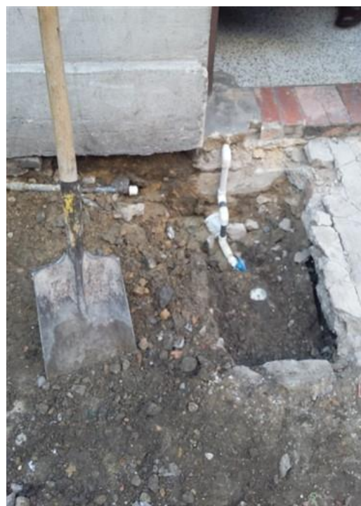
Figura 25. Tuberías de PVC halladas en el relleno bajo el adoquín retirado. Carrera 9 entre calle 12 y 12B, costado oriental.
