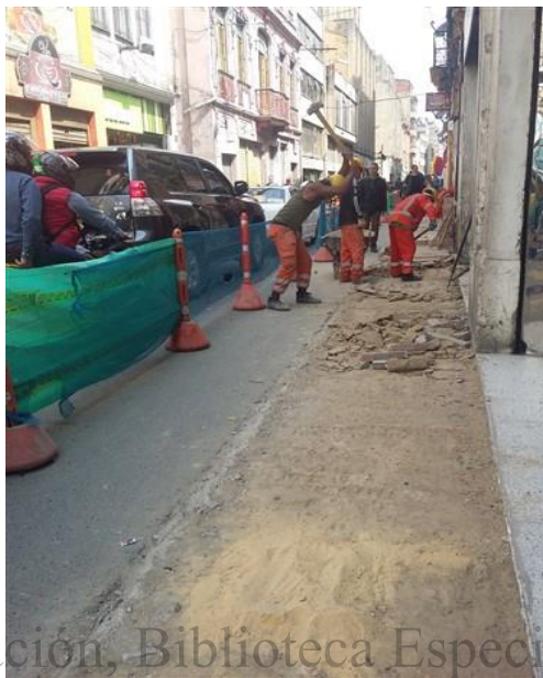
Figura 38. Intervención de andenes de la carrera 9 entre calles 12 y 12B, costado occidental.
