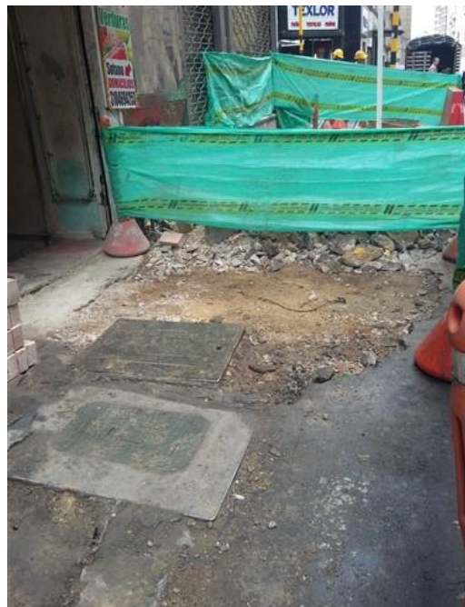
Figura 47. Relleno bajo la capa de adoquín. Calle 12b entre carreras 8a y 9, costado sur
