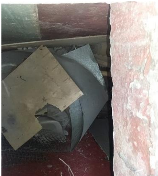
Figura 33. Fotografía del depósito subterráneo, materiales contemporáneos: triplex, plástico, rejilla de metal, loza de sanitario. Carrera 9 entre calle 12 y 12B, costado oriental.
