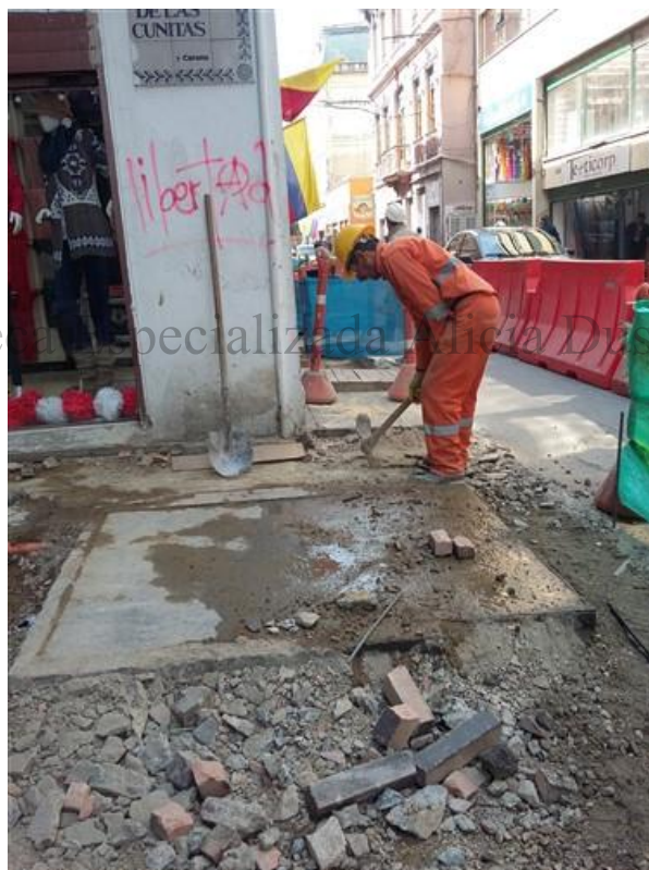
Figura 23. Remoción de adoquinería y suelo heterogéneo en la carrera 9 entre calle 12 y 12B, costado oriental.
