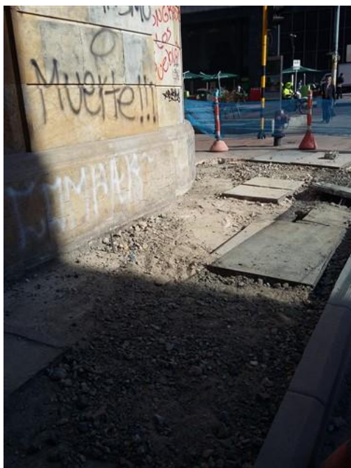
Figura 11. Terminación de la remoción del piso superficial en la esquina. Carrera 8 entre Av. Jiménez y Calle 12C costado occidental.
