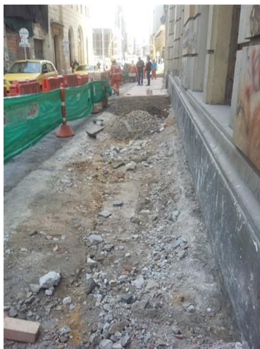
Figura 19. Relleno y nivelación de suelos. Carrera 8 entre Av. Jiménez y calle 12C, costado oriental
