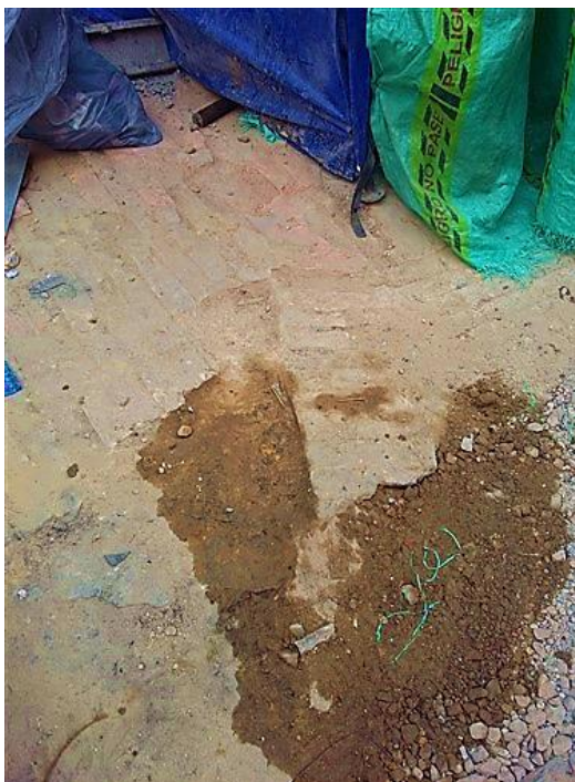
Figura 29. Estrato de adoquín bajo la capa removida. Profundidad: 10 cm. Carrera 9 entre calle 12 y 12B, costado oriental.
