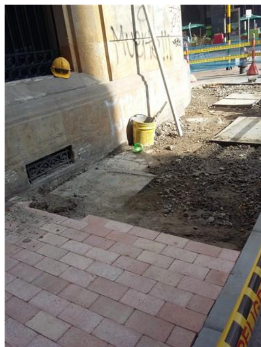
Figura 12. Compactación e inicio de instalación de adoquín. Carrera 8 entre Av. Jiménez y Calle 12C, costado occidental.
