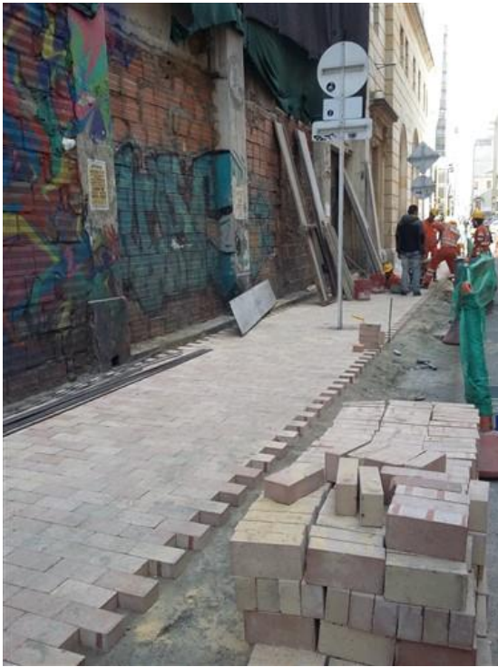
Figura 13. Proceso de instalación de adoquín. Carrera 8 entre Av. Jiménez y calle 12 C, costado occidental.
