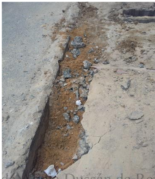
Figura 39. Relleno en arena y mortero bajo la placa de concreto. Carrera 9 entre calles 12 y 12B, costado occidental.
