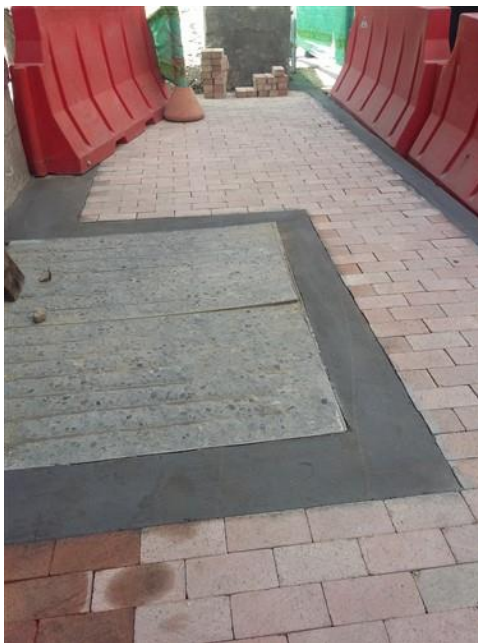
Figura 52. Adoquines y vigas terminadas en la calle 12b entre carreras 8a y 9 costado sur.
