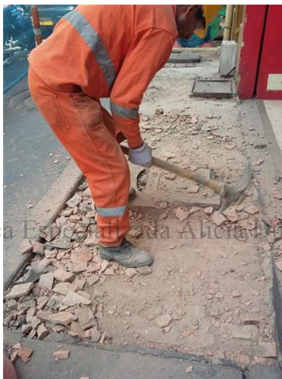
Figura 9. Remoción de la primera capa de concreto en deterioro. Carrera 8 entre Av. Jiménez y Calle 12C, costado occidental
