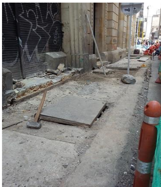
Figura 10. Placa homogénea de concreto a 10 cm de profundidad y cajas de recolección en la carrera 8 entre Av. Jiménez y Calle 12C. Costado occidental.
