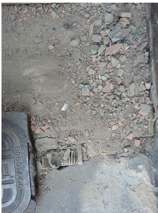
Figura 24. Rejilla plástica sobre la placa de concreto, carrera 9 entre calle 12 y 12B, costado oriental
