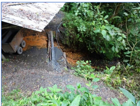
Fotos N°21 y 22. Afectaciones en el lugar por la instalación de la bocamina 1. Corte de talud en ladera.
