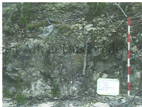
Foto 21. En el perfil 4 se aprecia el afloramiento de la roca y la desaparición casi por completo de la capa orgánica
