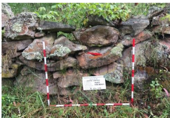
Fotografía 9 Muro en piedra Coordenadas: E977011 - N994114
