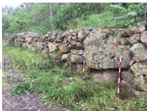
Fotografía 10 Muro en piedra Coordenadas: E976950 - N994262
