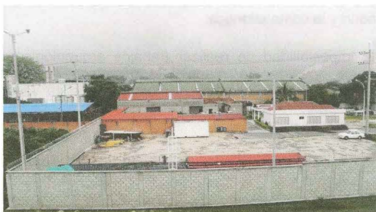
Foto N° 4. Vista de las Instalaciones de Transoriente en el parque Industrial de Chimita (municipio de Girón). Imagen captada desde el predio contiguo de la Estación Palenque. Como se aprecia el lugar fue intervenido hace tiempo, no solamente por las construcciones, sino también por las tuberías de gas que llegan a ese lugar.
