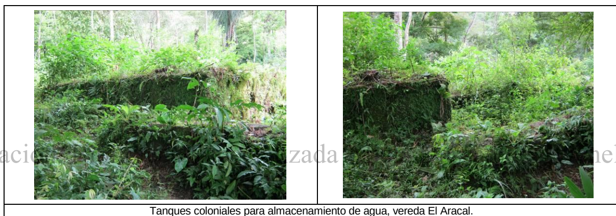
Tanques coloniales para almacenamiento de agua, vereda El Aracal.
