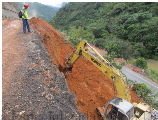
Fotografía 22. Actividades mes 3 (corte y remoción de tierras).
