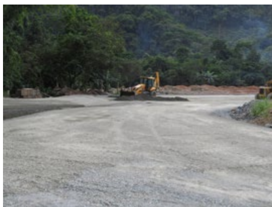
Fotografía 37. Actividades mes 2 (acumulación y compactación de materiales de relleno).
