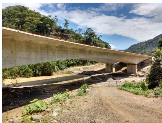
Fotografía 55. Estado de la obra mes 1.
