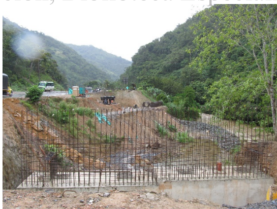
Fotografía 10. Actividades de ensamble de estructuras.
