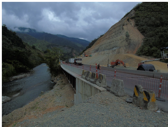
Fotografía 17. Actividades mes 6 (adecuación final).
