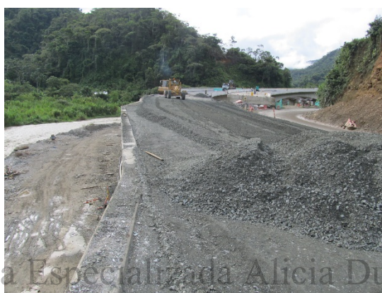
Fotografía 57. Estado de la obra mes 3.
