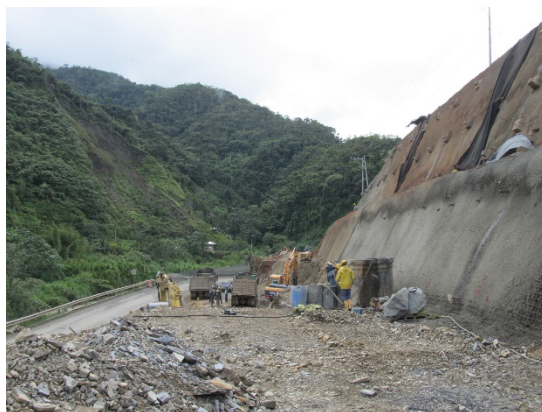
Fotografía 44. Actividades mes 3 (estabilización de taludes).
