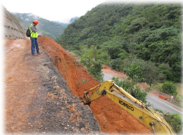
Fotografía 2. Inspección visual a actividades de remoción de tierras con pala mecánica.
