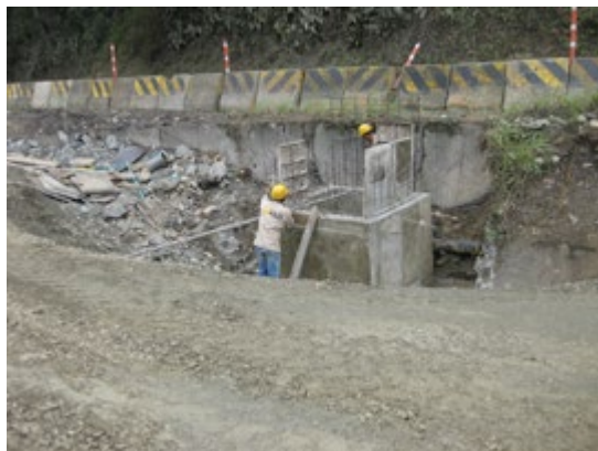
Fotografía 31. Actividades mes 4 (construcción de obras finales).
