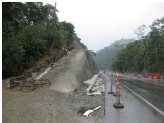
Fotografía 45. Actividades mes 4 (aplicación de capa de concreto al talud).
