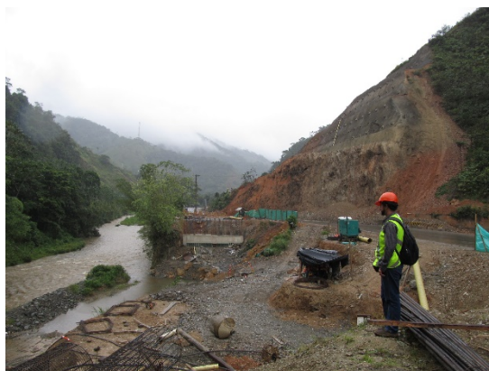
Fotografía 14. Actividades mes 3 (relleno y estabilización).
