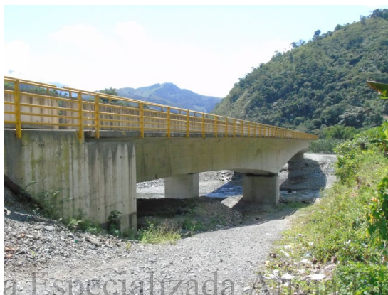
Fotografía 60. Estado de la obra mes 6.
