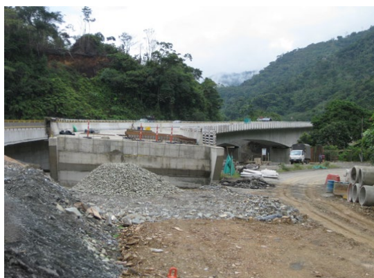
Fotografía 58. Estado de la obra mes 4.
