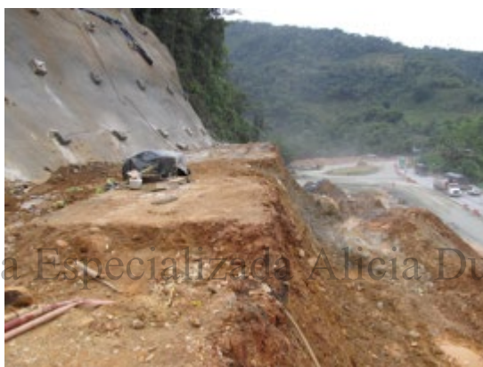
Fotografía 50. Actividades mes 2 (cortes y remociones en talud).
