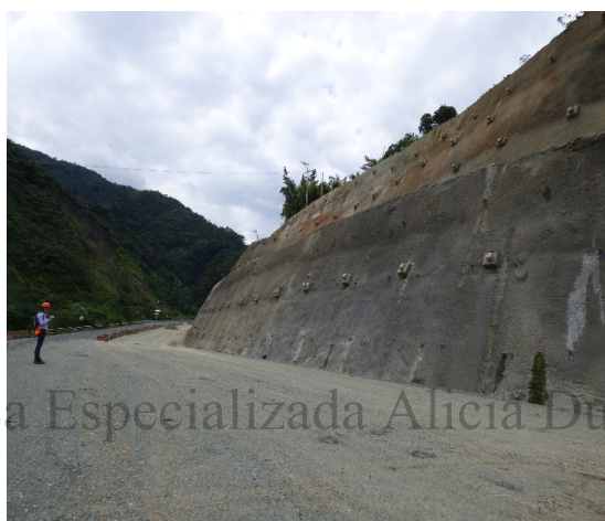
Fotografía 53. Actividades mes 5 (cobertura de capa de concreto).
