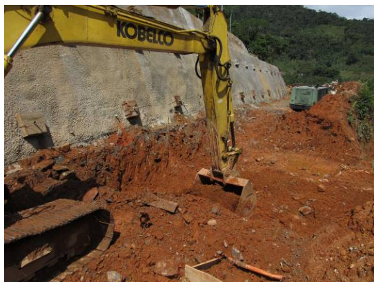
Fotografía 49. Actividades mes 1 (cortes y remociones en talud).
