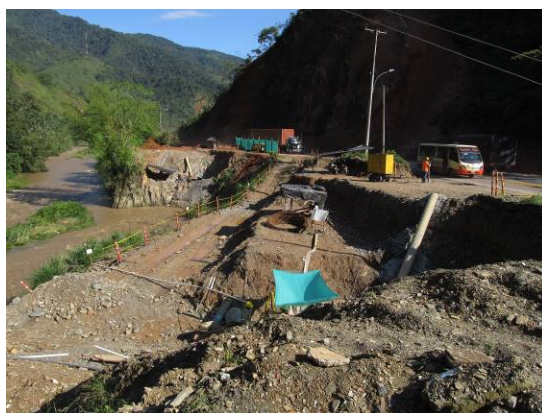
Fotografía 12. Actividades mes 1 (excavaciones y remociones).
