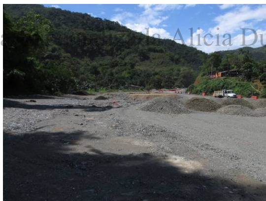
Fotografía 36. Actividades mes 1 (acumulación de materiales de relleno).
