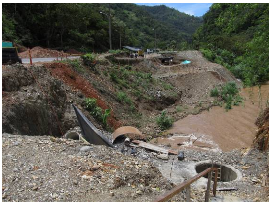
Fotografía 8. Registro de actividades iniciales de excavaciones y movimientos de tierra (Puente Paraguas).
