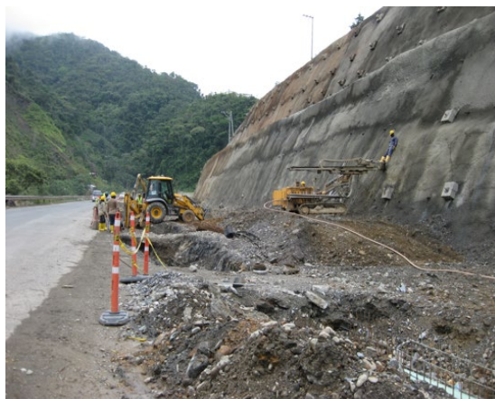
Fotografía 52. Actividades mes 4 (estabilización de taludes).
