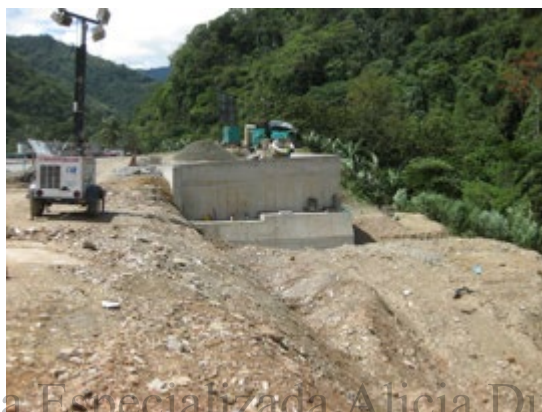
Fotografía 15. Actividades mes 4 (relleno y estabilización).
