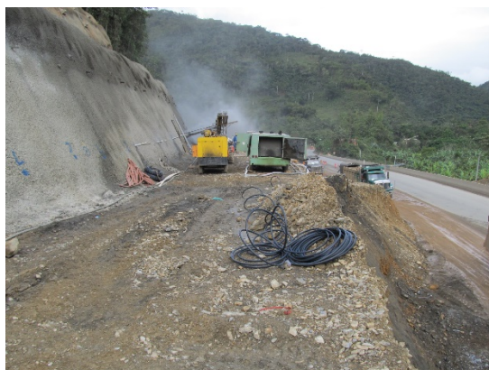
Fotografía 51. Actividades mes 3 (estabilización de taludes).
