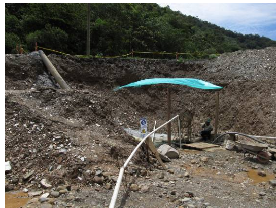
Fotografía 9. Registro de actividades iniciales de excavaciones y movimientos de tierra (Puente Paraguas).
