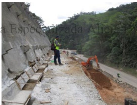
Fotografía 43. Actividades mes 2 (cortes y remociones de tierra en ladera de montaña).
