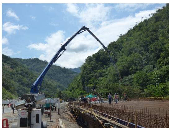
Fotografía 16. Actividades mes 5 (construcción y ensamble).
