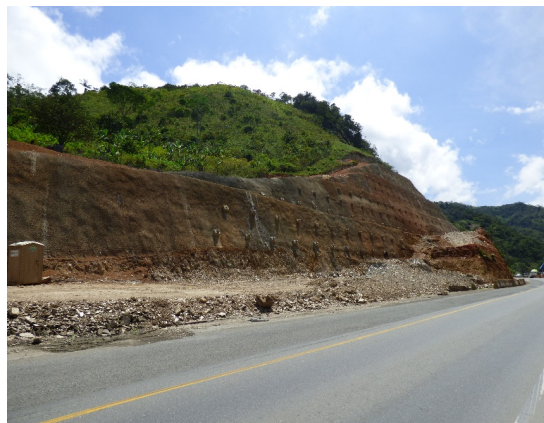
Fotografía 24. Actividades mes 5 (estabilización de taludes).
