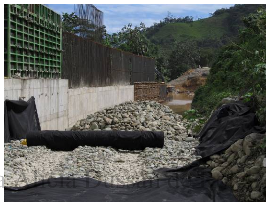
Fotografía 27. Proceso constructivo del Muro Sombrerillos (acumulación de materiales de relleno).
