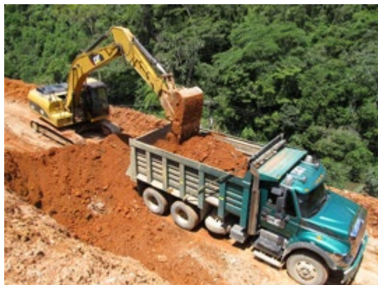
Fotografía 21. Actividades mes 2 (corte y remoción de tierras).
