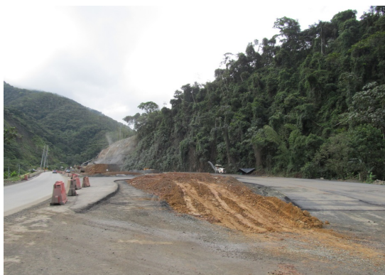
Fotografía 38. Actividades mes 3 (acumulación y compactación de materiales de relleno).
