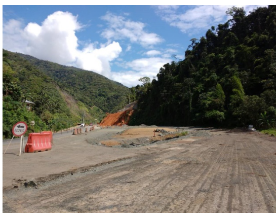
Fotografía 35. Estado inicial de las obras en Retorno Cementerio.
