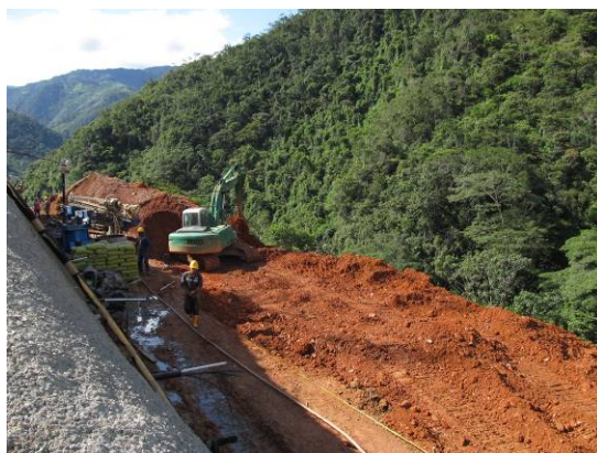
Fotografía 20. Actividades mes 1 (corte y remoción de tierras).
