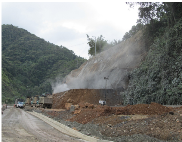
Fotografía 48. Sector de corte y adecuación del Talud Treschorros.
