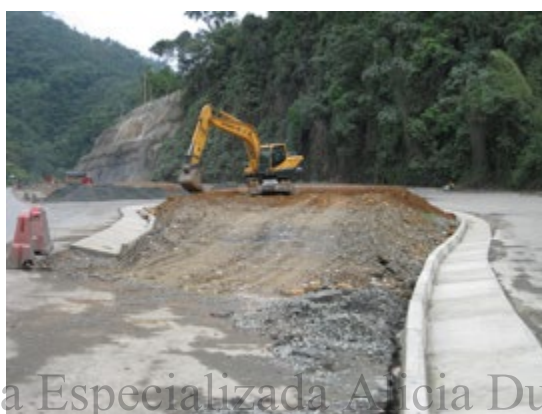
Fotografía 39. Actividades mes 4 (acumulación y compactación de materiales de relleno).
