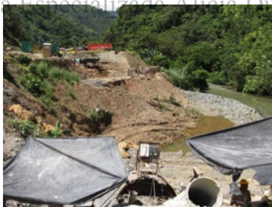
Fotografía 13. Actividades mes 2 (excavaciones y remociones).
