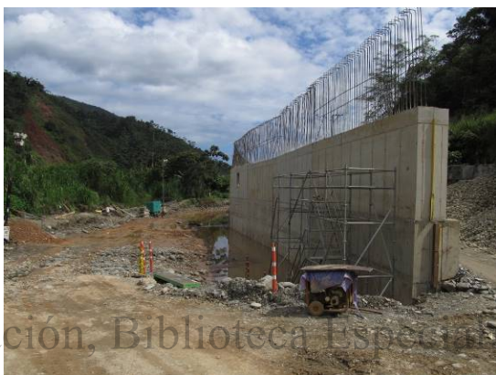
Fotografía 26. Proceso constructivo del Muro Sombrerillos.
