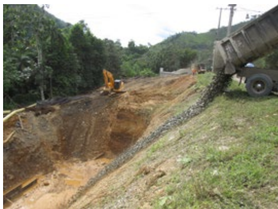
Fotografía 28. Actividades mes 1 (excavación y relleno).
