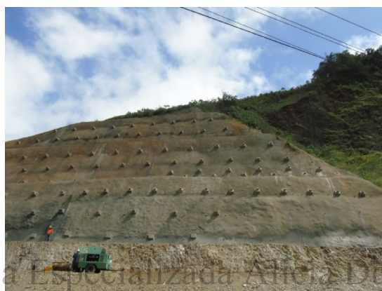
Fotografía 25. Actividades mes 6 (cobertura final de taludes mediante placa de concreto).
