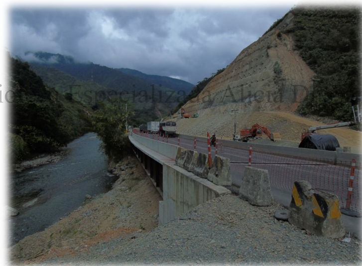
Fotografía 6. Ejemplo del estado final de las obras en el puente Paraguas registrado durante la última visita.
