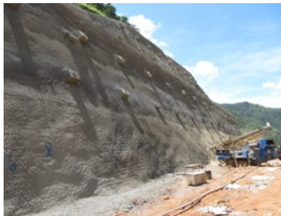
Fotografía 19. Estabilización final mediante cobertura de concreto.
