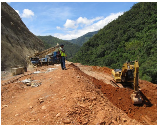
Fotografía 18. Cortes y remociones de tierras.
