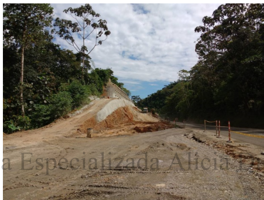
Fotografía 34. Estado inicial de las obras en Talud Cementerio.
