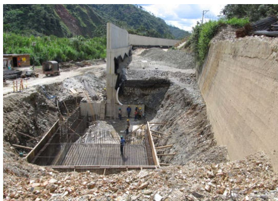
Fotografía 29. Actividades mes 2 (relleno y construcción de bases).
