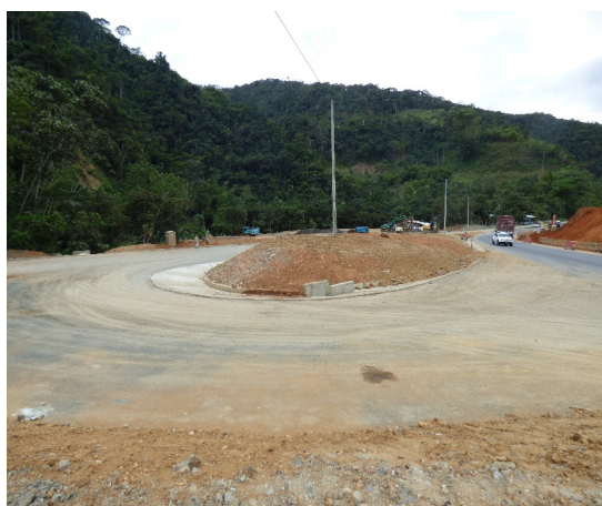
Fotografía 40. Actividades mes 5 (adecuación de la vía).
