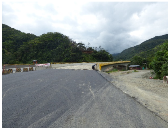
Fotografía 59. Estado de la obra mes 5.
