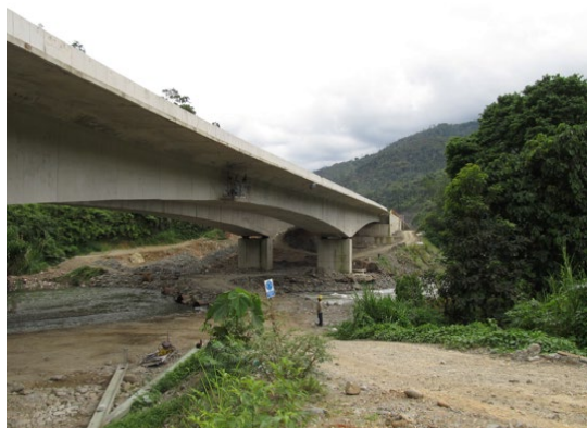
Fotografía 56. Estado de la obra mes 2.
