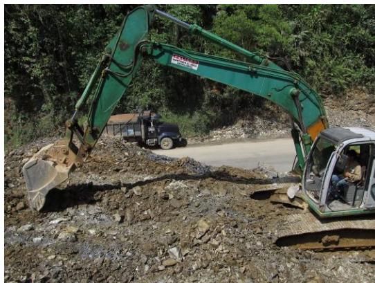
Fotografía 42. Actividades mes 1 (cortes y remociones de tierra en ladera de montaña).
