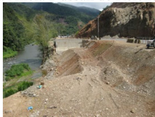
Fotografía 11. Relleno y estabilización.
