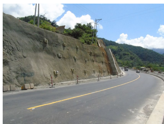
Fotografía 54. Actividades mes 6 (cobertura de capa de concreto).
