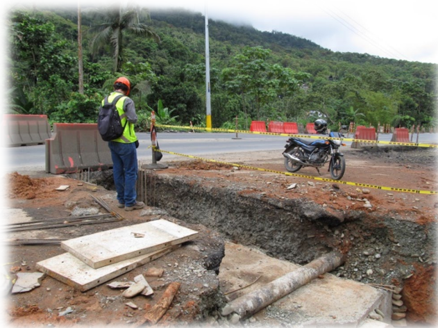
Fotografía 1. Inspección visual a actividades de remoción de tierras.
