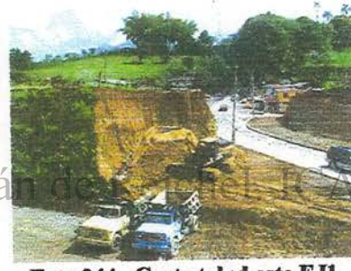
Foto 244. Corte talud este EJ1
