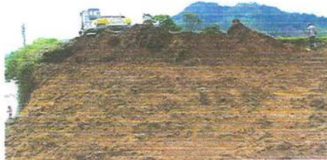
Foto 223. Seguimiento máquina talud EJ1
