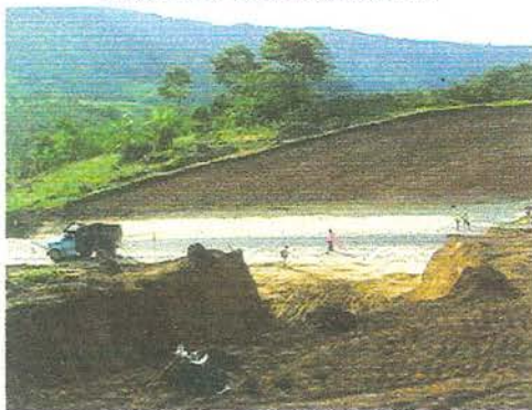
Foto 198. Corte de talud oeste en EJ1
