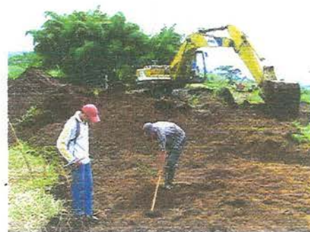
Foto 224. Limpieza de rasgos EJ1
