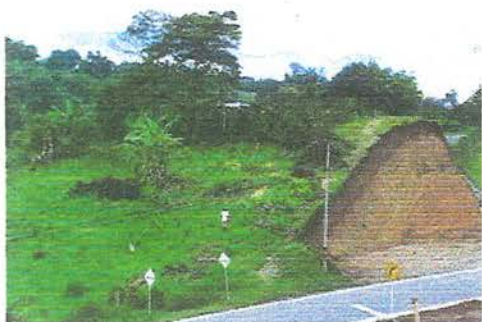
Foto 196. Talud Oeste EJ1
