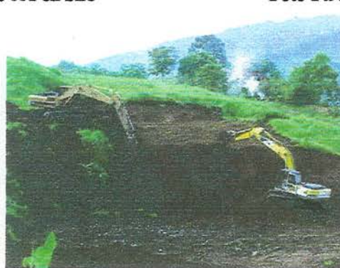
Foto 151. Construcción eje 001 en SB3
