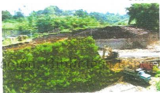
Foto 242. Corte del talud oriental EJ1
