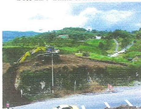
Foto 222. Remoción talud este EJ1
