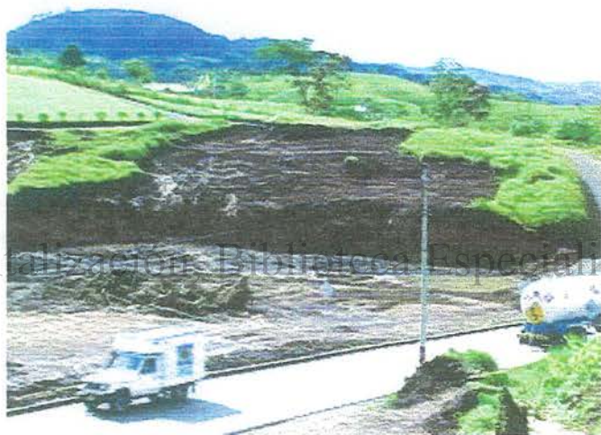
Foto 148. Panorámica afectación Eje 001 en SB3
