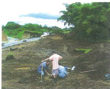
Foto 153. Excavación EV1 SB3
