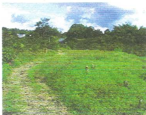
Foto 201. Anillo vial Eje 001, vista S-N
