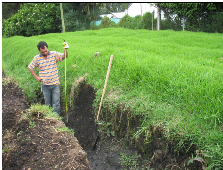
Foto 3. Limpieza y revisión de perfil en canal existente.
