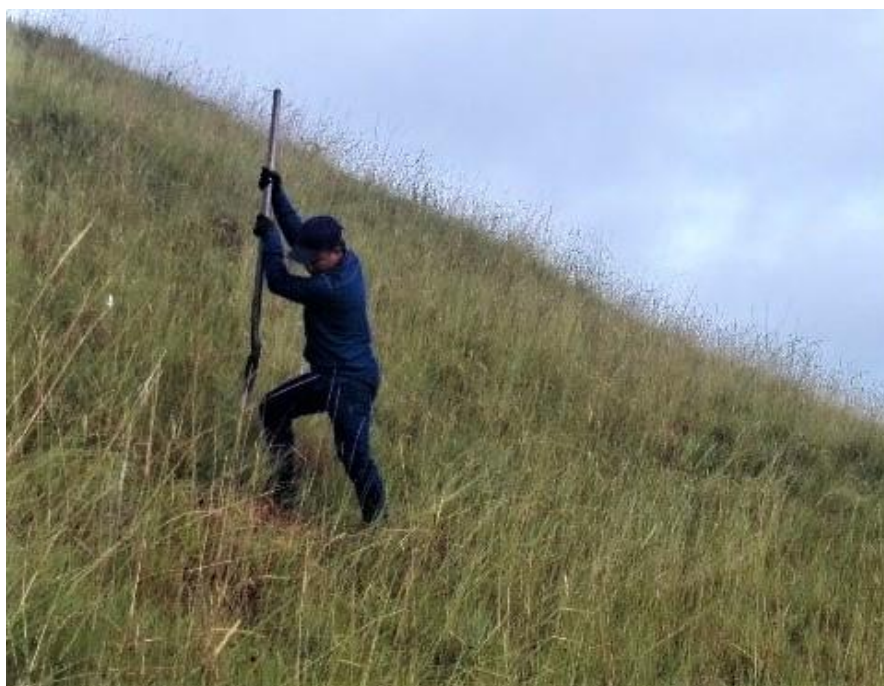
Fotografía 17. Elaboración de los pozos de sondeo en el área donde se construirá el Pozo Vertical Ópalo 43
