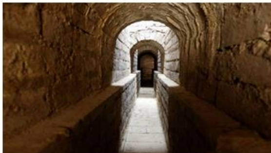
Estructura del canal de descarga al desarenadero. Construido por Antonio J. Duque en 1896. Fuente: proyecto Tranvía de Ayacucho. Fuente Metro de Medellín.
