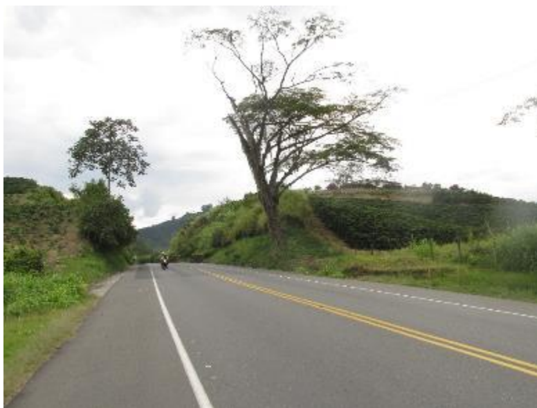
Fotografía 6-3. Área de los sondeos 1 al 7
