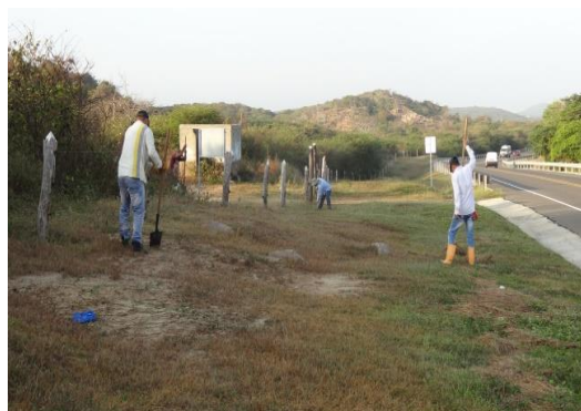
FOTO 33. EXCAVACIÓN DE POZOS DE SONDEO PARTE INICIAL DE LA VÍA
