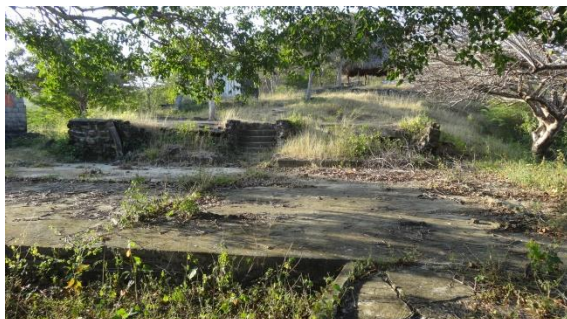
FOTO 28. CIMIENTOS DE VIVIENDA ZONA DE LADERA 3
