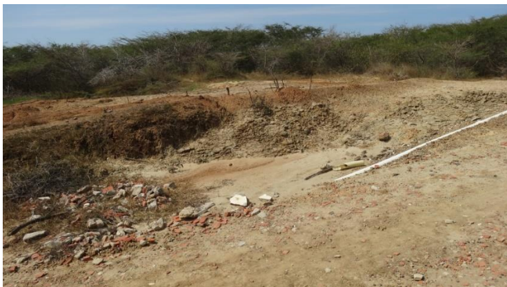
FOTO 31. TRAMO INICIAL DE LA VÍA
