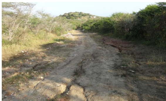
FOTO 35. TERCER TRAMO DE LA VÍA
