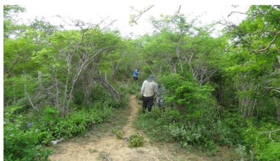
FOTO 14. REALIZACIÓN POZOS DE SONDEO TA4
