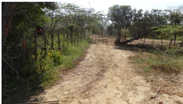
FOTO 38. PARTE FINAL DE LA VÍA
