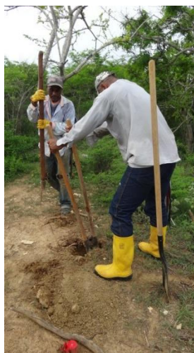
FOTO 10. REALIZACIÓN POZOS DE SONDEO TA2
