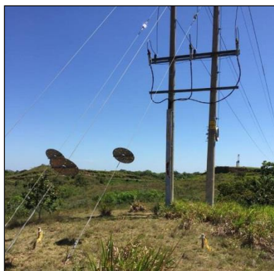
Fotografía 3 Detalle templates en estructura Tipo R4, actualmente en funcionamiento en Campo Rubiales.
