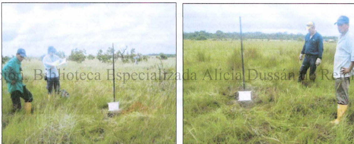
Fotografías 1 y 2: realización de pozos de sondeo en el área de los EPF's Atarraya 1 y 2.
