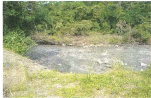
Imagen 55. Inspección en terrazas primarias y orillas del río Tobia.
