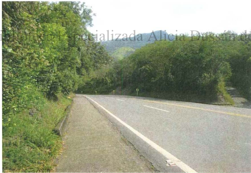
Imagen 37. Alteración del paisaje en los alrededores de la vía pavimentada.
