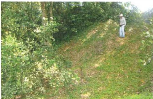
Imagen 21. Terraza con presencia de material de relleno.
