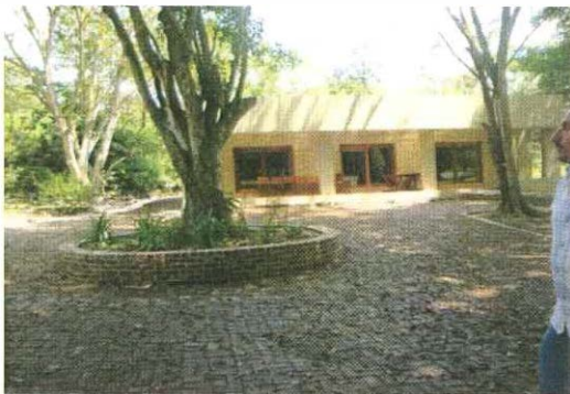
Imagen 23. Terrenos con presencia de relleno artificial.
