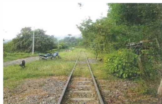
Imagen 30. Inspección del área adyacente a la carrilera.
