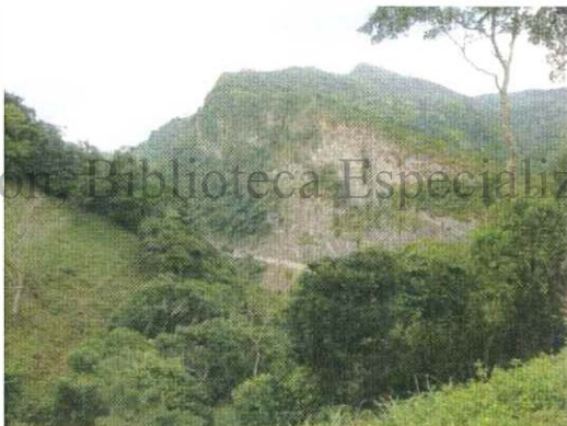
Imagen 76. Áreas de fuerte pendiente en el sector sur del bloque ICEIN.
